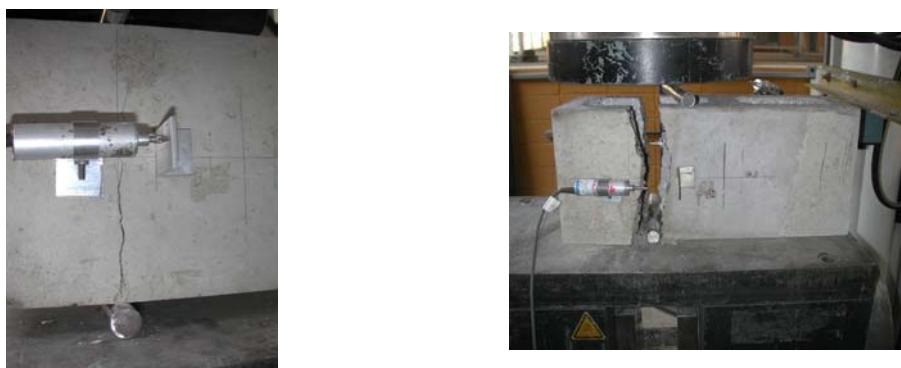
Figura 4.18 – Fissuração no bloco de concreto quando submetido à tração indireta.
