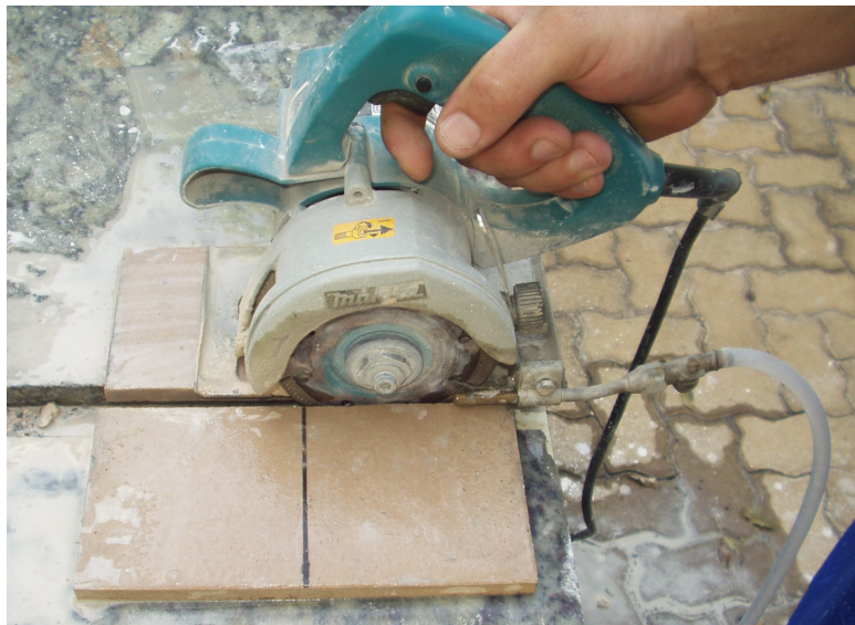
Figura 3.22 – Corte de peça com serra policorte e disco rotativo diamantado ( \varnothing 110 mm)
