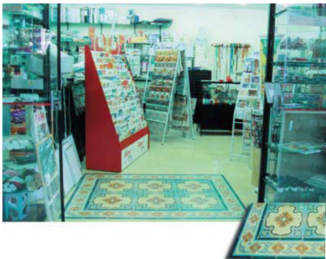
Figura 2.13 – Ladrilhos hidráulicos em imóvel comercial (SALTENSE, 2006)
