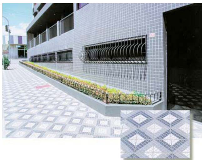
Figura 2.14 – Ladrilhos hidráulicos em ambiente externo (SALTENSE, 2006)
