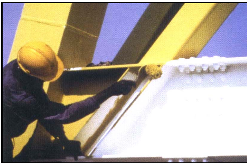
Figura 3.24 – Aplicação da tinta intumescente. Fonte: DIAS (2002).
