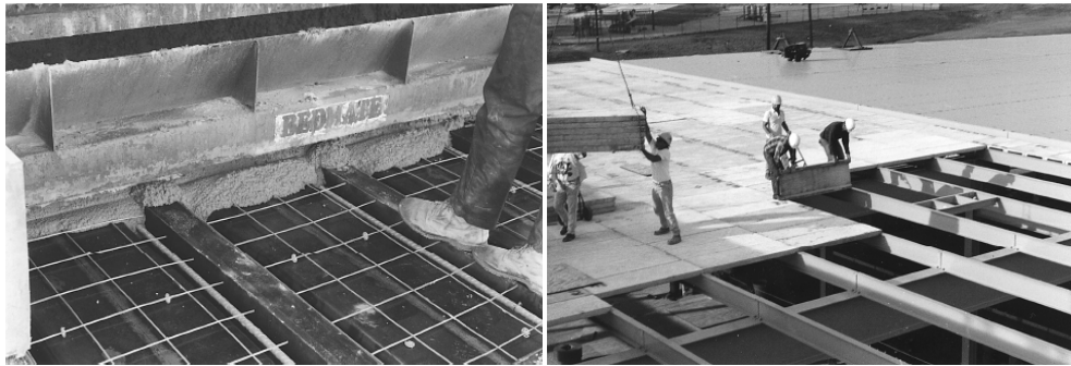
Figura 1.4 – Construção e execução de lajes pré-moldadas na Geórgia (ACI 440 R, 1996)
