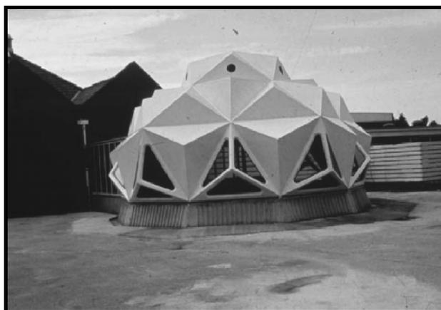
**Figura 2.4** - Utilização de GFRP em estrutura.
