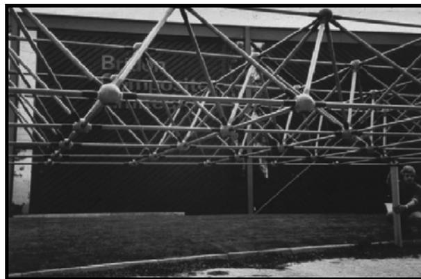
**Figura 2.6** – Estrutura produzida com perfis de FRP pultrusados.
