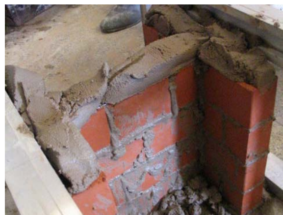
e) Construção da última fiada (cinta)
