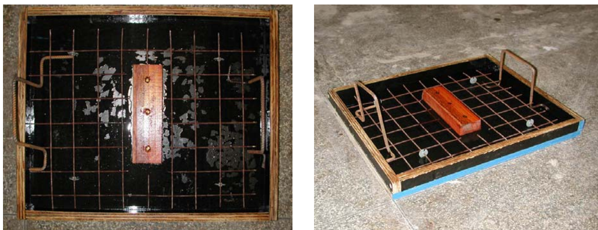
Figura 4.3 – Fôrmas e armaduras das lajes
