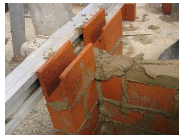
f) Colocação do bloco canaleta (cinta)
