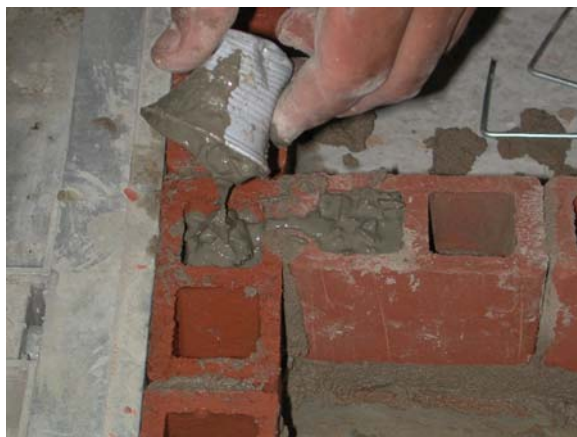
a) Colocação do graute para ligação com grampo
