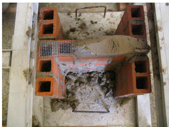
c) Assentamento da argamassa
