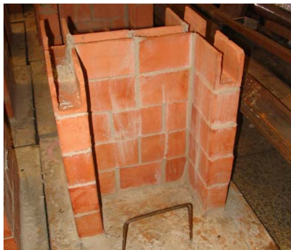
b) Espera para grauteamento da cinta
