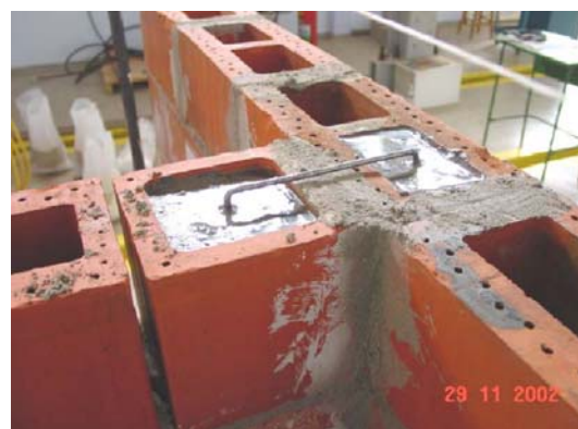
b) Detalhe do grampo metálico grauteado
