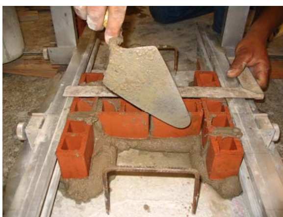
c) Execução da primeira fiada
