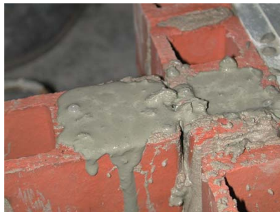
b) Furo do bloco preenchido com graute
