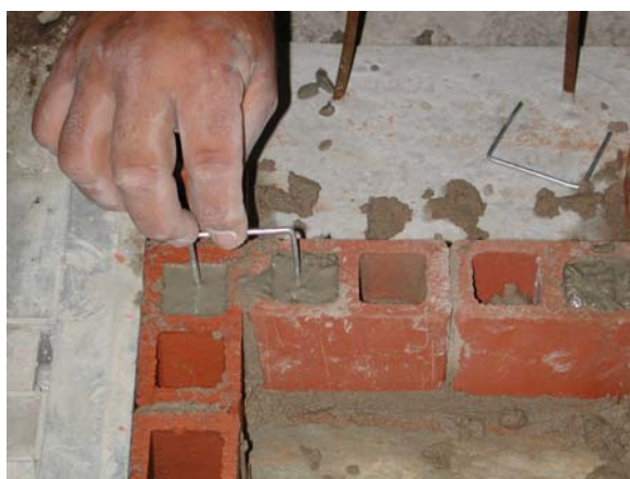
c) Colocação do grampo
