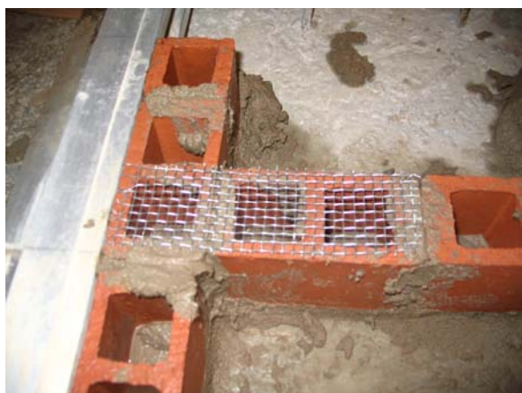
a) Colocação da tela
