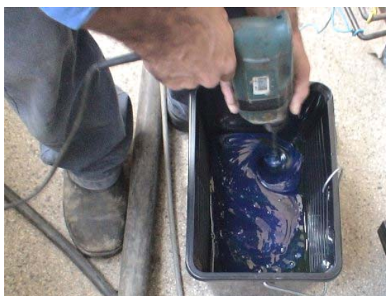
a) mistura mecânica do adesivo epóxi
