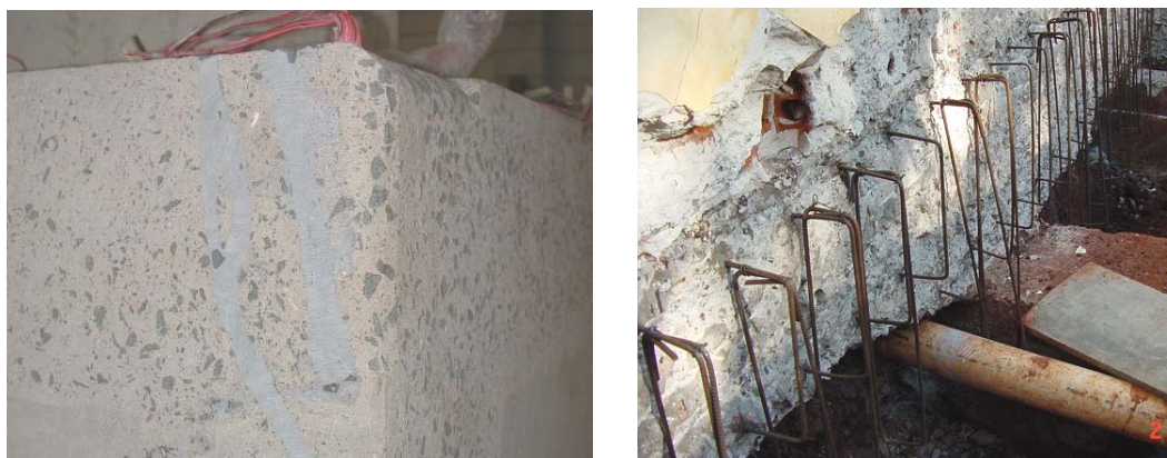
a) reparo localizado em bloco de concreto
