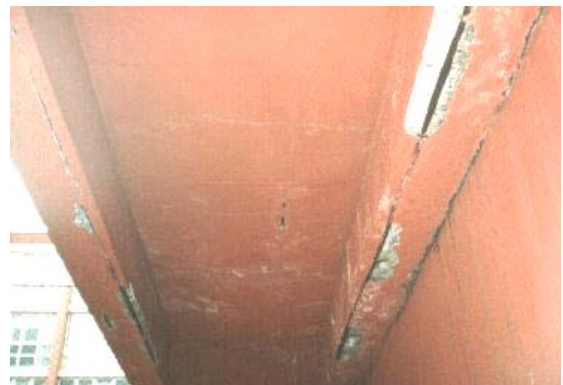
b) viga de passarela
