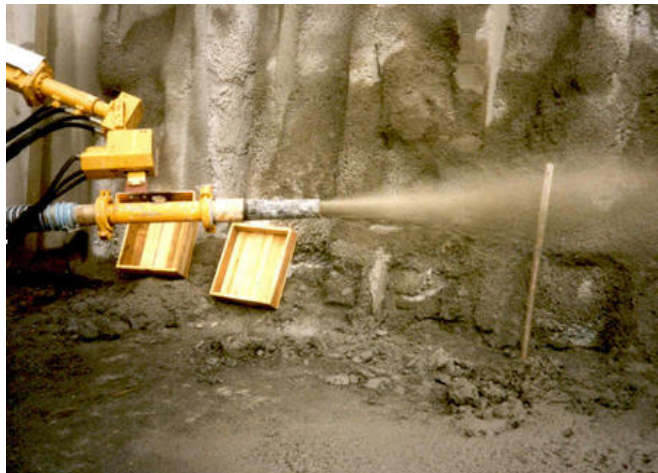
Figura 2.8 – Concreto projetado com fibra de aço
