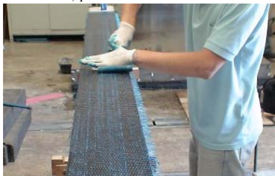
d) pressionamento com rolete metálico
