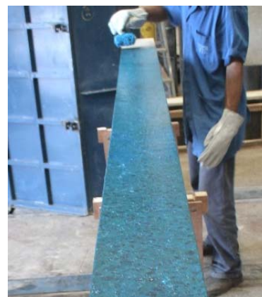
b) aplicação do epóxi
