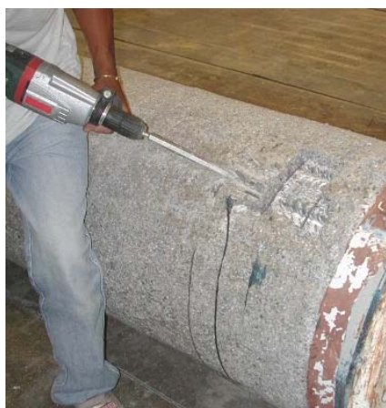
a) remoção da região danificada com uso de martelo rompedor elétrico
