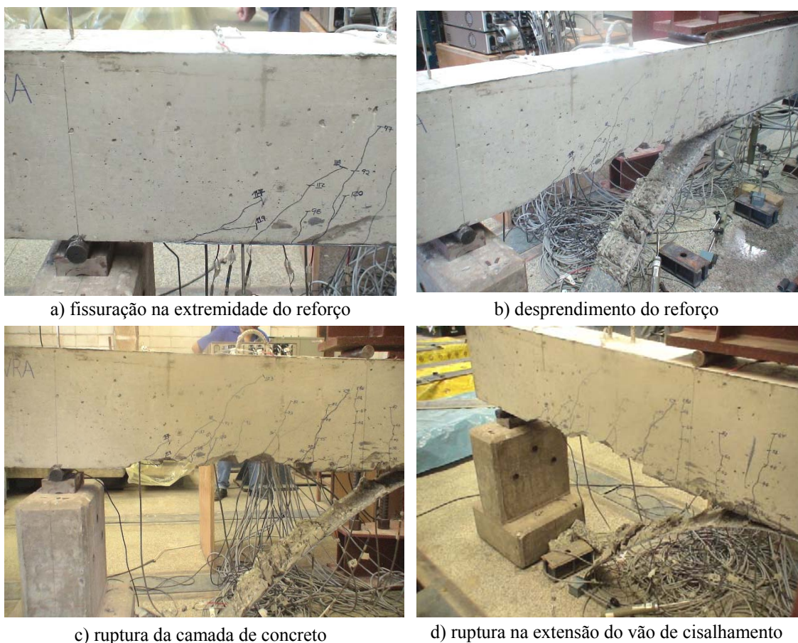
Figura 8.10 – Detalhes da ruína da viga V1C
