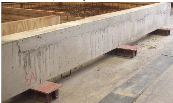
e) aspecto da viga após reconstituição
