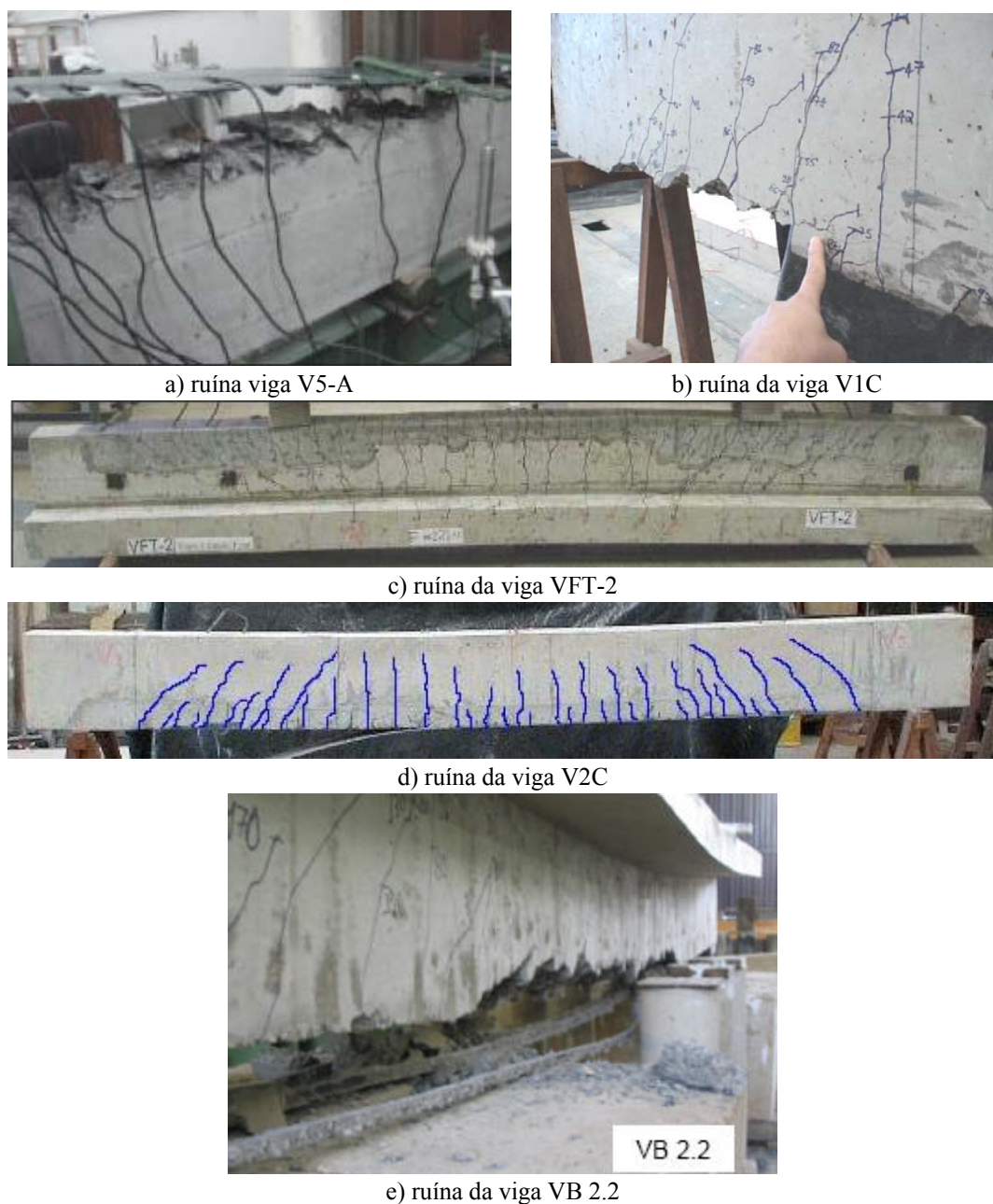
Figura 8.32 – Comparação dos modos de ruína das vigas reforçadas
