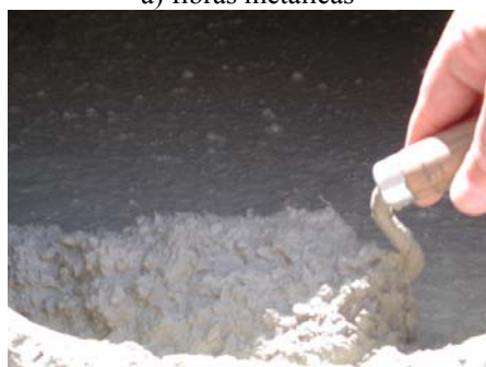
c) compósito no interior da betoneira
