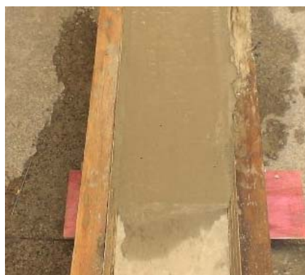
d) detalhe do acabamento da superfície
