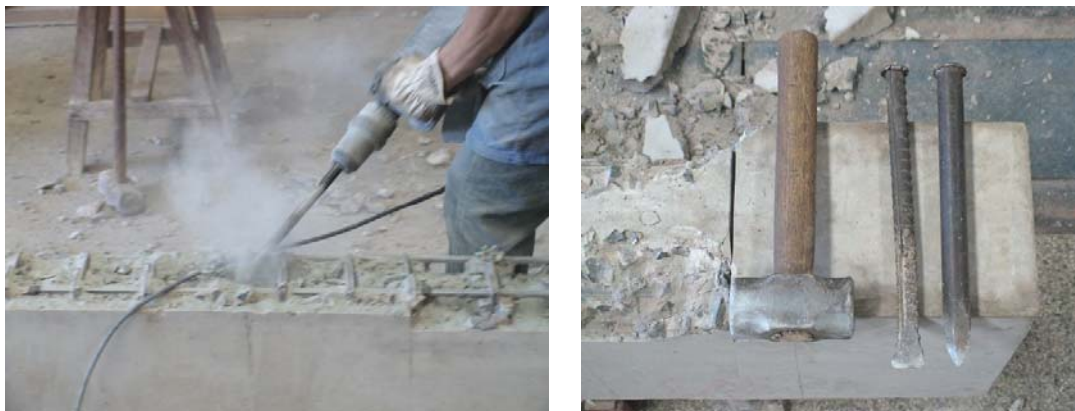
Figura 7.7 – Remoção do concreto
