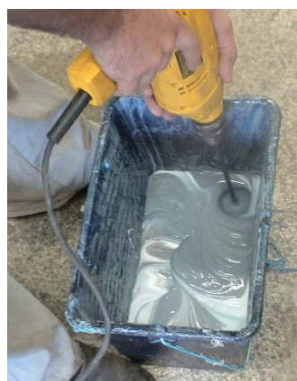
b) mistura mecânica do adesivo
