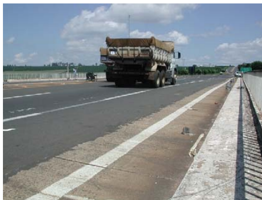
b) caminhão percorrendo o viaduto
