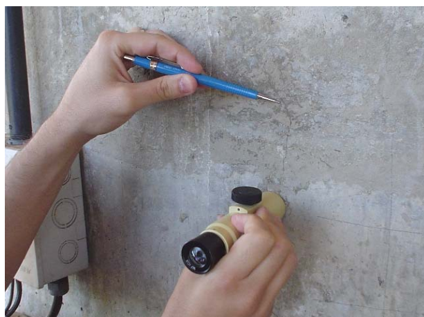
a) avaliação do tamanho da abertura de fissura na superfície de concreto
