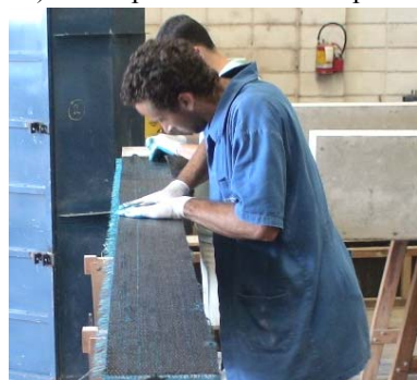
c) pressionamento da manta
