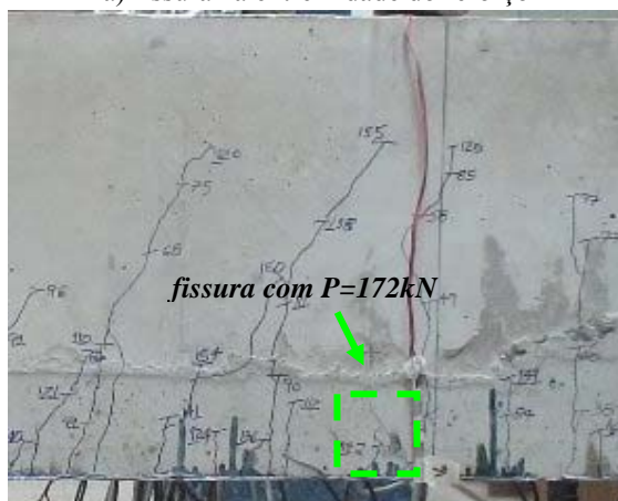
c) fissura na seção de aplicação da força durante o ensaio
