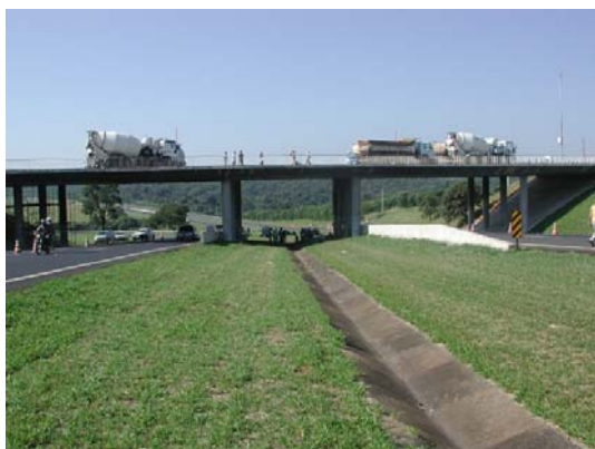
a) caminhões posicionados sobre o viaduto
