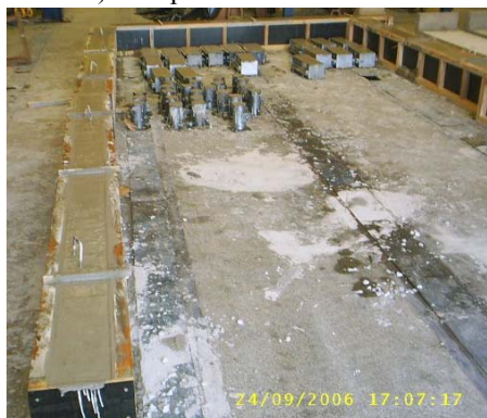
d) vigas concretadas
