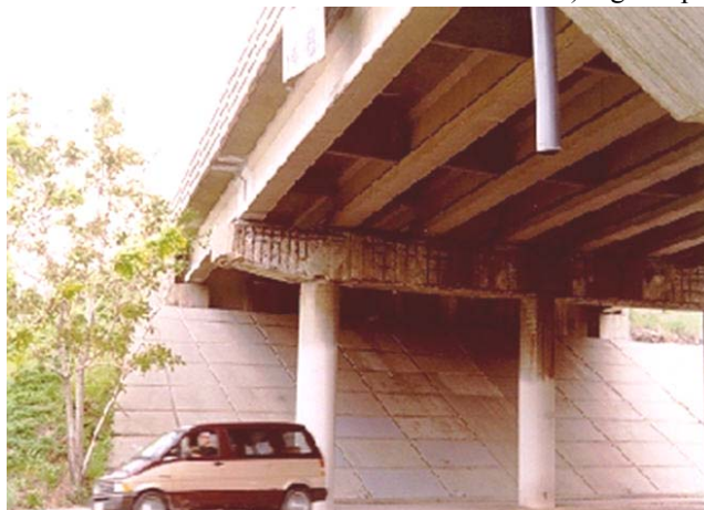
c) vigas de viaduto
