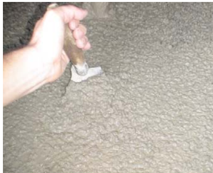
d) microconcreto no interior da betoneira
