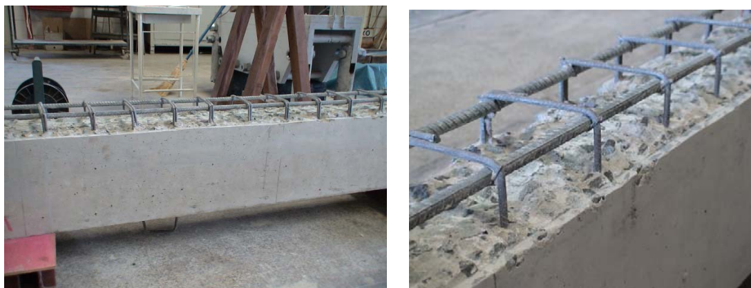
Figura 7.8 – Detalhe da superfície do banzo tracionado após a remoção do concreto – Viga V2C
