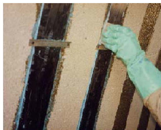
b) aplicação do laminado (GETTU, 2002)
