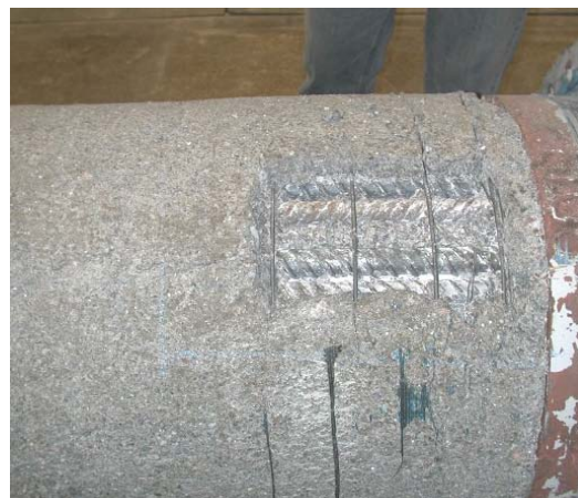
b) região de concreto removida
