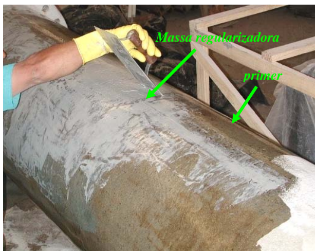
Figura 3.13 – Detalhe da imprimação e correção de pequenas irregularidades do substrato de concreto
