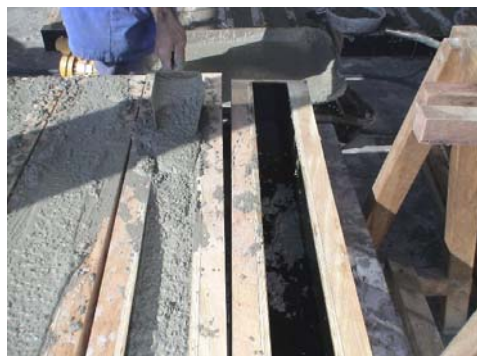
e) moldagem das vigas
