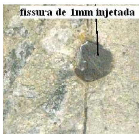
b) injeção de fissuras
