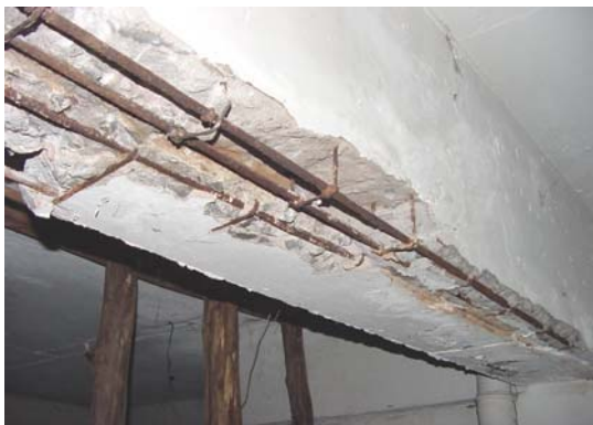
a) viga de edifício residencial
