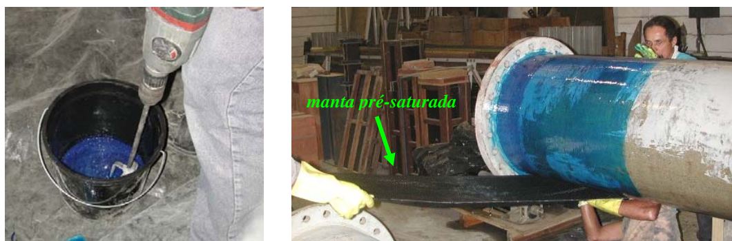
a) mistura mecânica do adesivo
