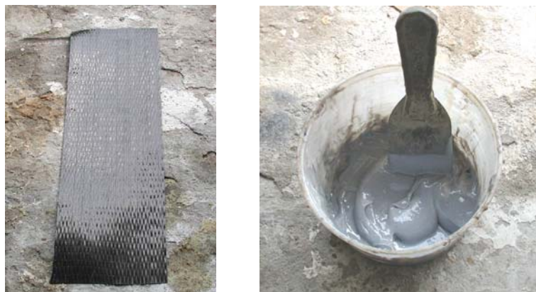
a) manta já cortada
