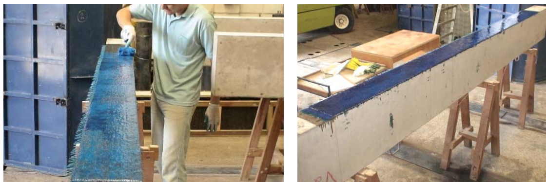
a) sobreposição de epóxi sobre a manta
