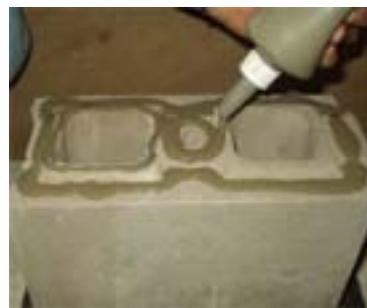
Figura 5.9. Mistura (i) e aplicação de pasta de cimento colante (ii).
