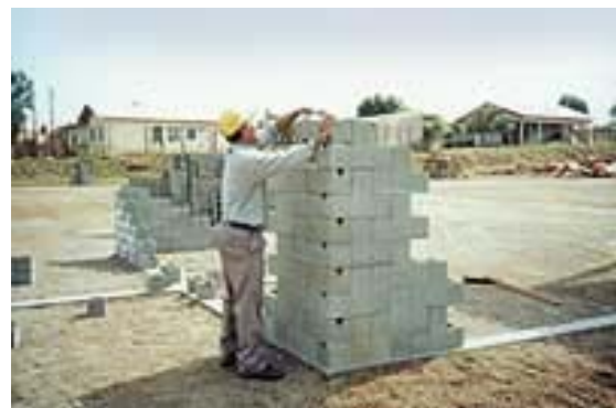
Figura 3.19. Assentamento a seco de blocos em proposição (fonte: GRASSIOTTO, 2000)
