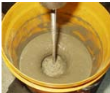
Figura 5.9. Mistura (i) e aplicação de pasta de cimento colante (ii).
