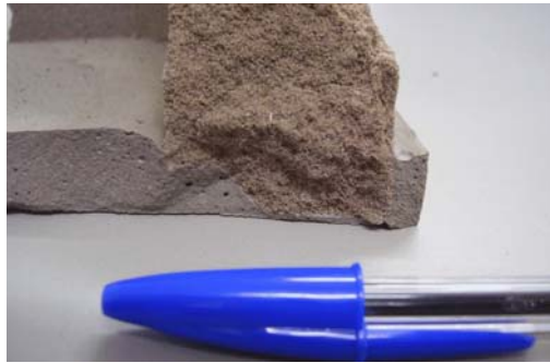
Figura 5.3. Detalhe do capeamento executado.
