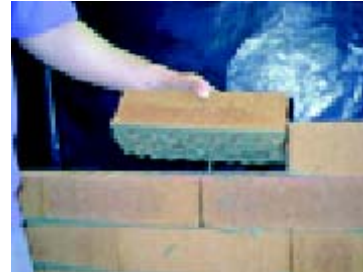
Figura 3.18. Aplicação de argamassa em bloco SillyBlock (i) e assentamento (ii) (fonte: www.somontar.com.br ).
