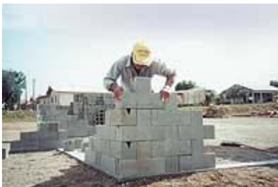
Figura 3.19. Assentamento a seco de blocos em proposição (fonte: GRASSIOTTO, 2000)
