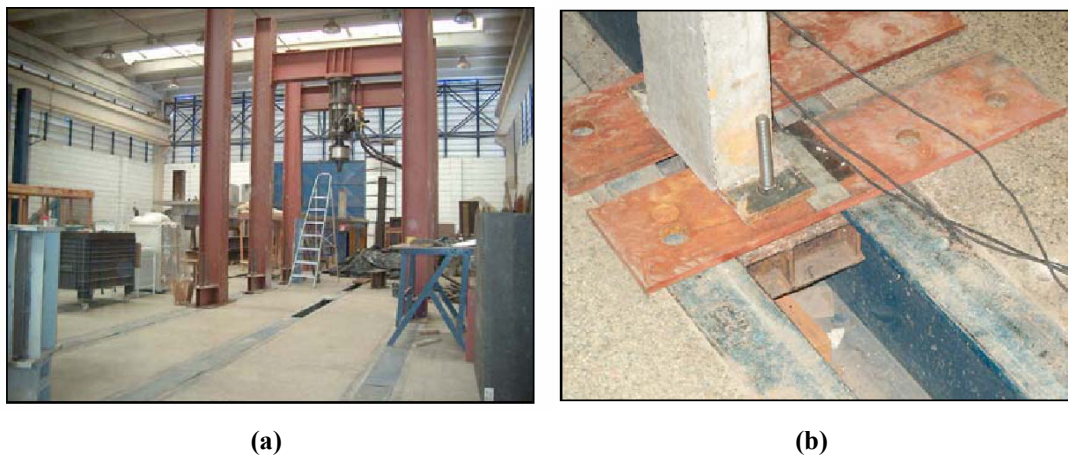
Figura 6.21 – Fixação do pórtico 1: (a) laje de reação, (b) detalhe da fixação, NÓBREGA (2004)
