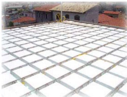
FIGURA 2.35 - Laje treliçada bidirecional
