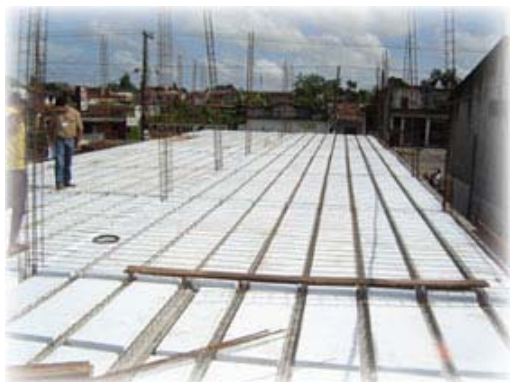
FIGURA 2.34 - Laje treliçada unidirecional
