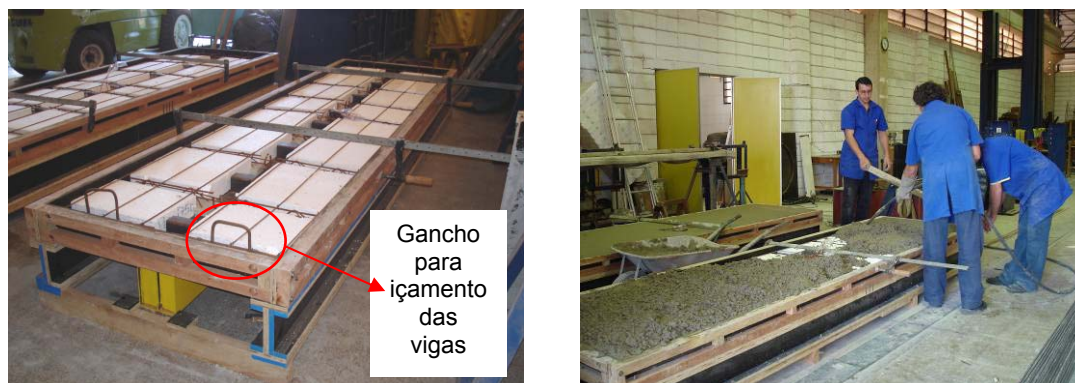
FIGURA 3.20 – Fôrmas e concretagem das vigas mistas
