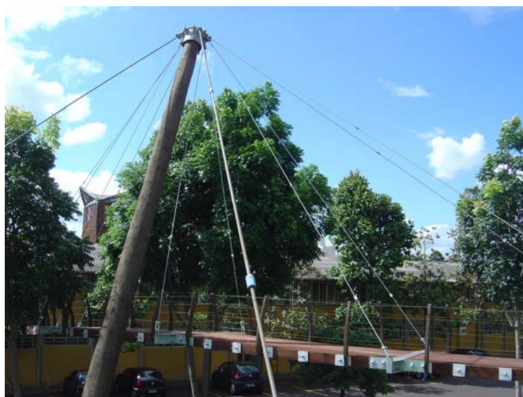
Figura 2 – Exemplo de estrutura empregando elemento roliço: primeira passarela estaiada do Brasil.
