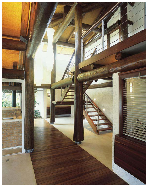
Figura 1 – Interior de habitação: pilares e vigas roliças de madeira
