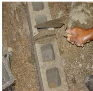
b) execução da junta vertical de argamassa
