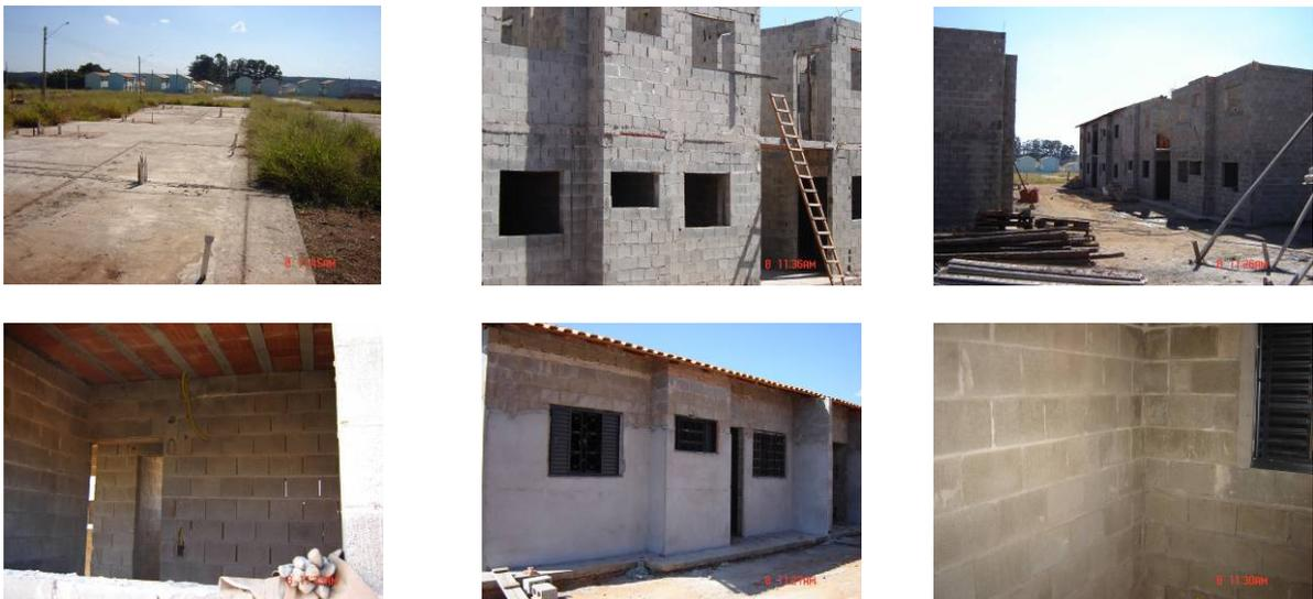
Figura 2.10 – Casas construídas com blocos de agregados reciclados (foto do autor).
