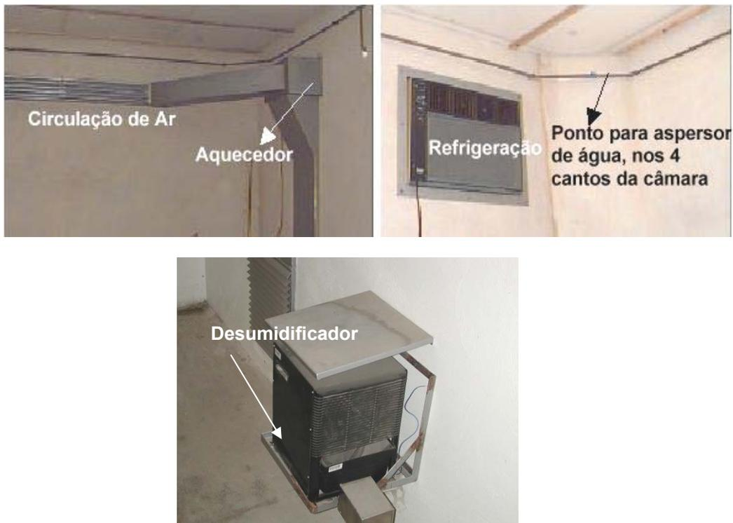
Figura 9.10 – Equipamentos de refrigeração, aquecimento, desumidificação e umidificação existentes na câmara climatizada.
