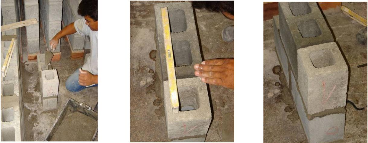
Figura 37 – Execução da segunda fiada.
