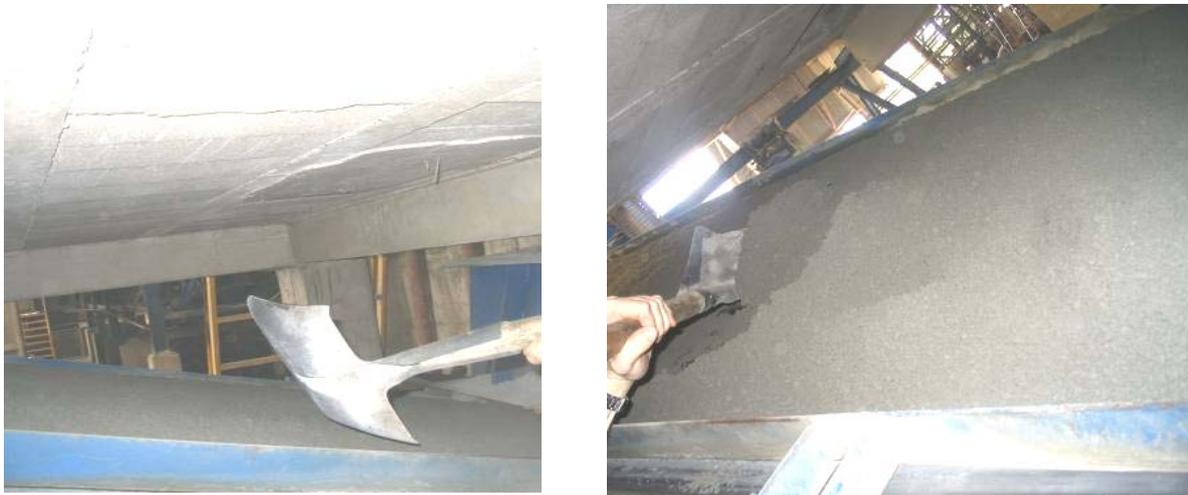
Figura 6.6 – Retirada das amostras de concreto para a produção dos corpos-de-prova.
