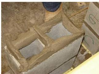
a) aplicação da segunda junta de argamassa
