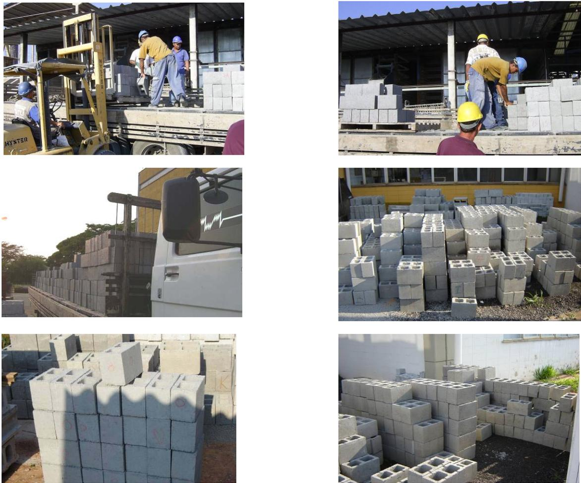
Figura 7.13 – Transporte/estocagem dos blocos.
