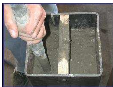
b) Adensamento do concreto
