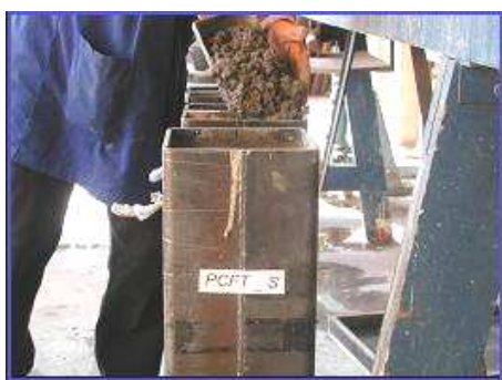
a) Lançamento do concreto
