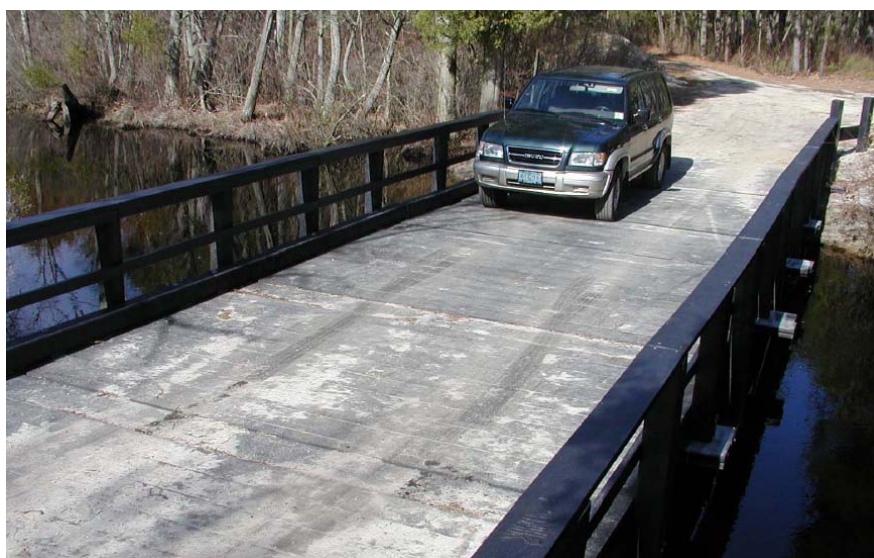
Figura 2.10. Ponte sobre o rio Mullica construída inteiramente de plástico
