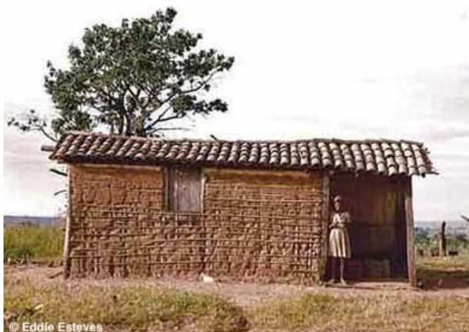
Figura 2.2. Casa de pau à pique típica do sertão nordestino brasileiro Fonte: http://www.cactos.com.br
