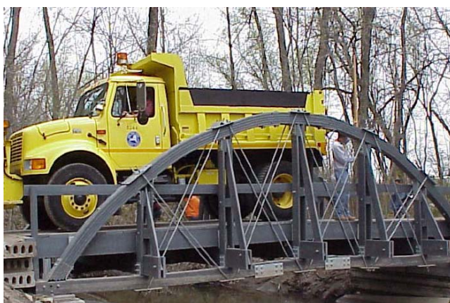
Figura 2.7. Ponte sobre o rio Hudson construída com plástico reforçado com fibra de vidro
