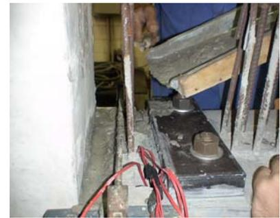
Grauteamento entre viga/pilar e rasgo da viga
