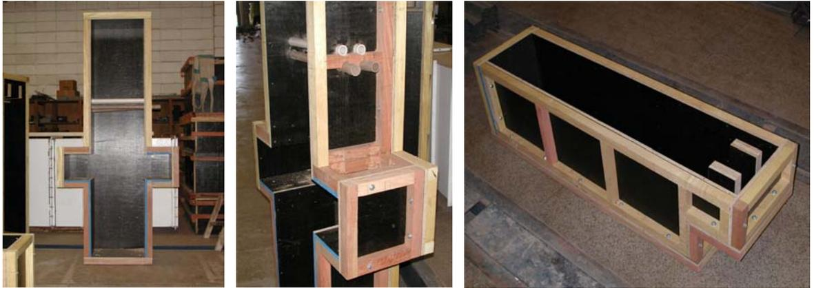
Figura 3.11 - Fôrmas das vigas e do pilar
