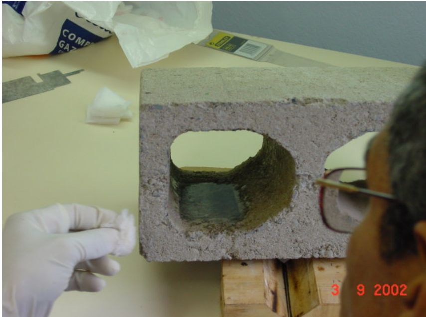
Figura 446 - Procedimento de limpeza e desengraxe do local de colagem.
