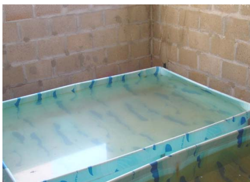
Figura 327 - Piscinas utilizadas na prova de carga.
