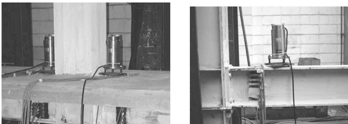
Figura A.7: Inclinômetros posicionados sobre a laje e sobre a viga de aço, respectivamente
