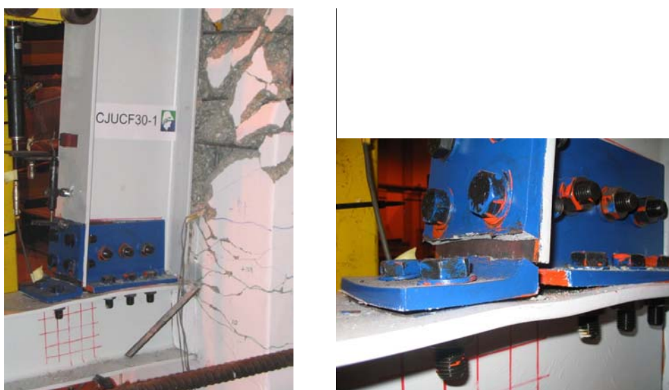
Figura 4.69: Detalhe da ruptura da cantoneira de assento
