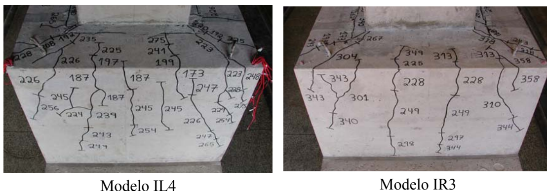
Figura 4.10 – Fissuração no topo da parede transversal 1 dos Modelos IL4 e IR3
