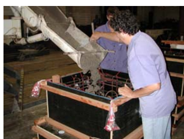
1º) Concretagem da base da fundação
