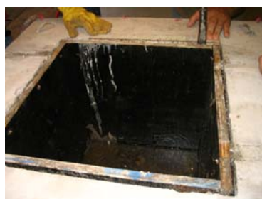
1º) Dissolução do poliestireno expandido com solvente
