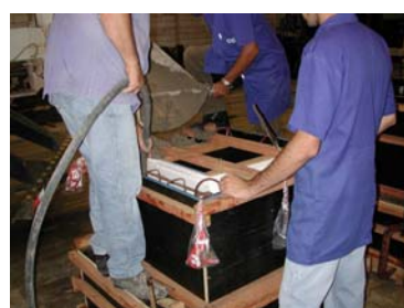
3º) Concretagem do colarinho
