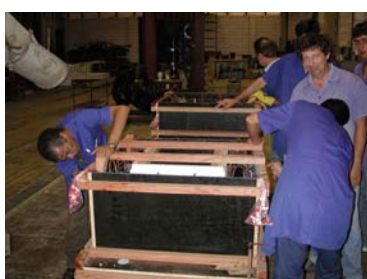
2º) Colocação da parte interna da fôrma
