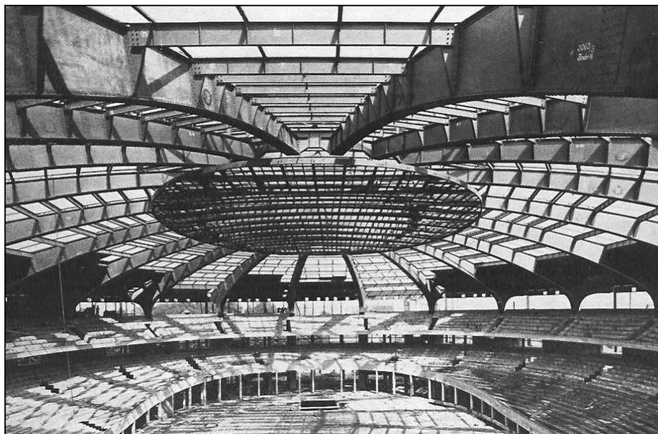
Figura 2.17 – Cúpula nervurada com anéis em alma cheia (Fonte: MAKOWSKI (1989))
