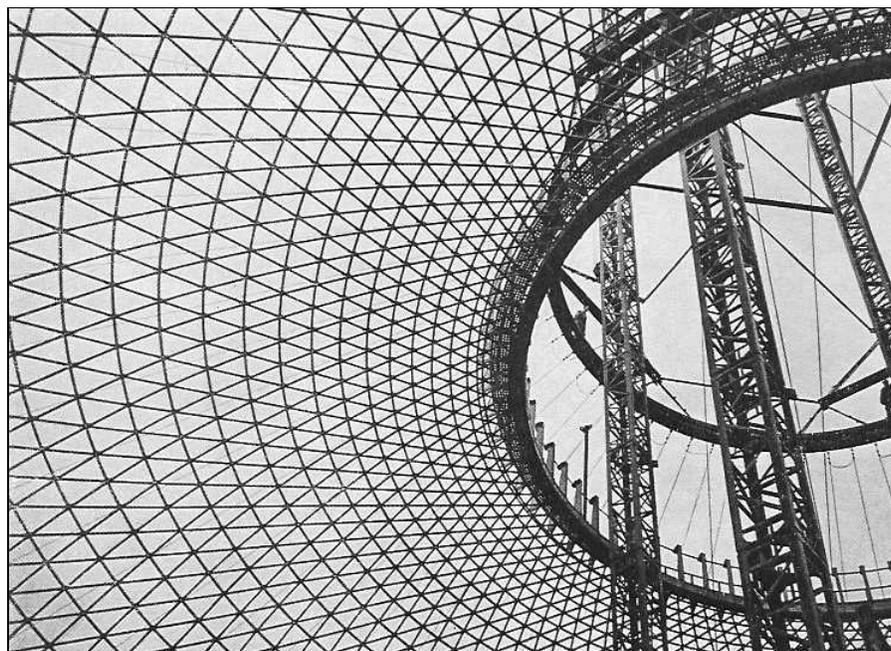
Figura 2.23 – Cúpula com malha simples em três direções (Fonte: MAKOWSKI (1989))
