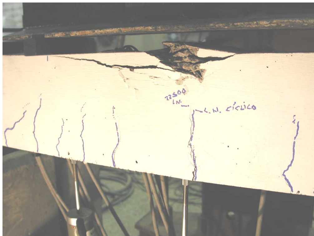
Figura 5.39 – Esmagamento do concreto na viga com armadura dupla
