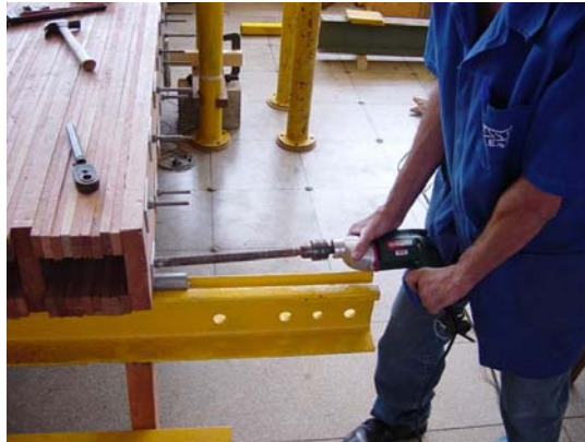
Figura 104 – Protensão do tabuleiro
