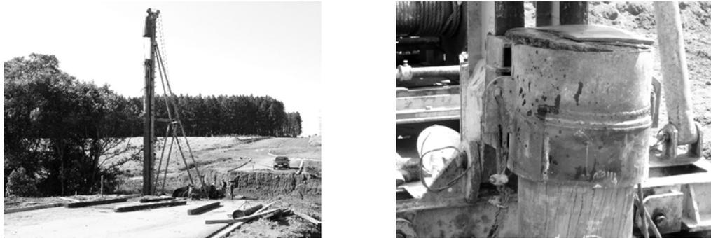
Figura 27 – Bate-estacas, martelo, e capacete
