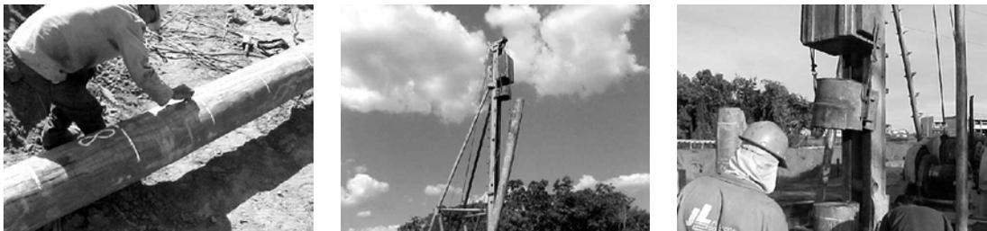
Figura 28 - Marcação, levantamento da estaca, e detalhe do capacete pendurado ao martelo
