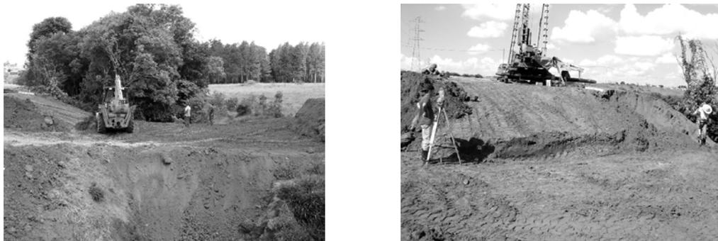
Figura 26 – Aterro de acesso e locação das estacas.
