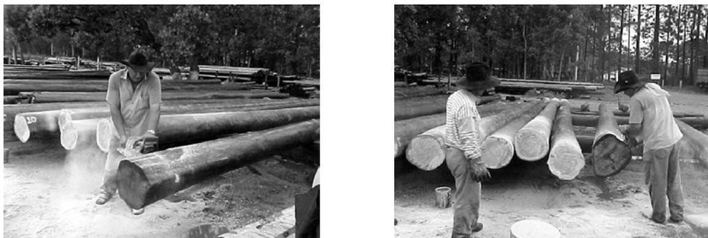
Figura 24 – Peças e discos retirados das extremidades das estacas
