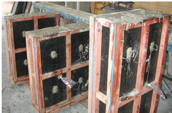
Figura 4.37 – Moldagem dos pilares
