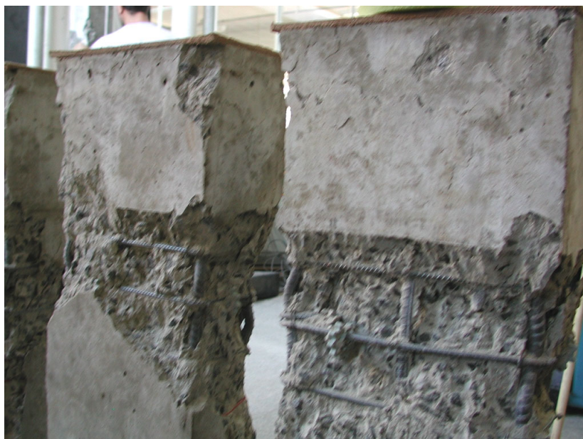
Figura 5.10 – Extremidades intactas dos pilares após o ensaio
