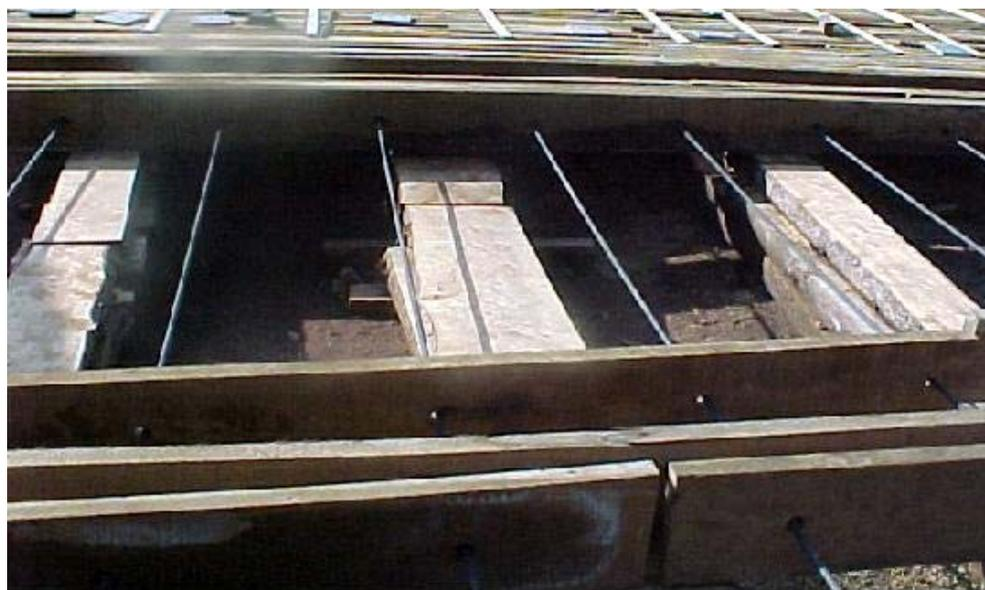
**Figura 53** – Montagem inicial do tabuleiro laminado.
