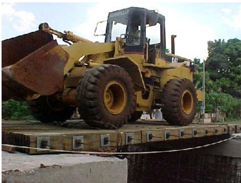
**Figura 58** – Primeiro veículo a atravessar a ponte, antes da verificação das forças de protensão.
