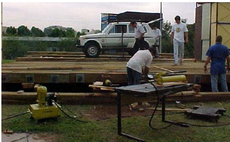
**Figura 60** - Sistema montado para monitoramento da perda de protensão no tabuleiro.
