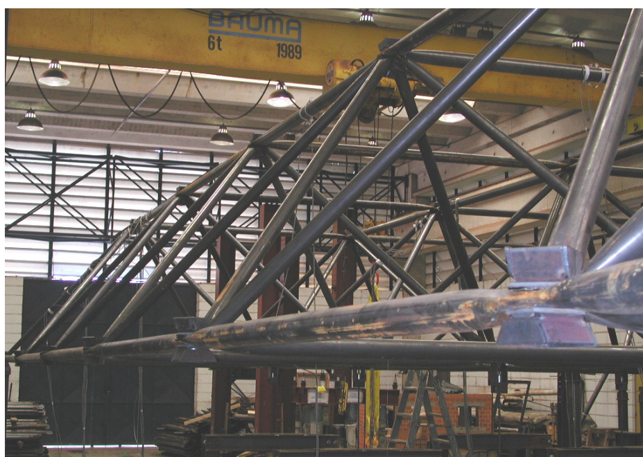
Figura 4.3 - Vista geral da treliça TE1-R
