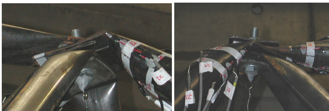
Figura 4.70 - Configuração de colapso do nó de canto da treliça TE2
