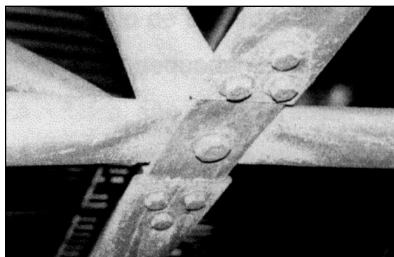
Figura 2.29 - Nó típico com chapa complementar
