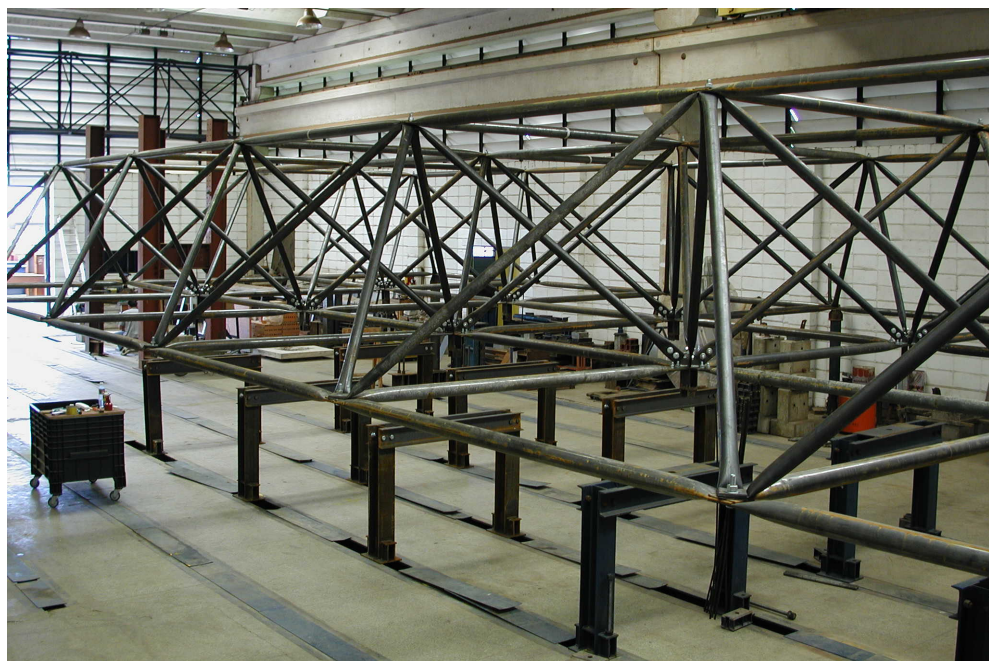
Figura 4.1 - Visão geral da treliça TE1
