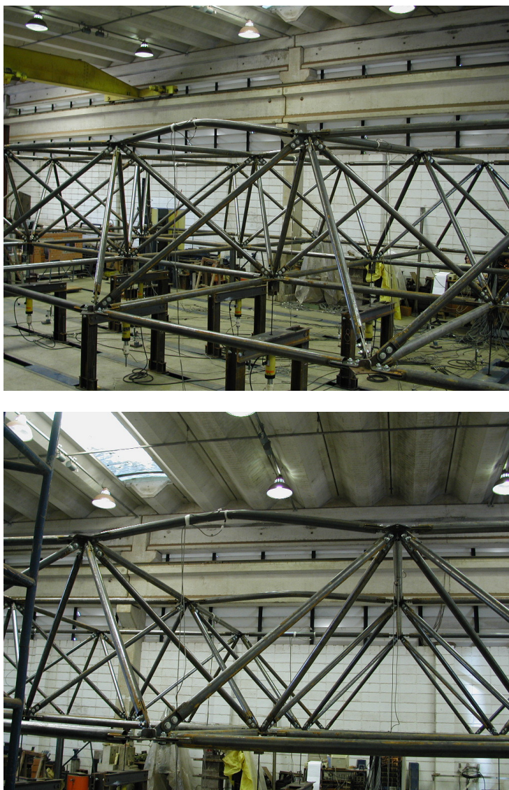
Figura 6.5 - Configuração de colapso da treliça TE5
