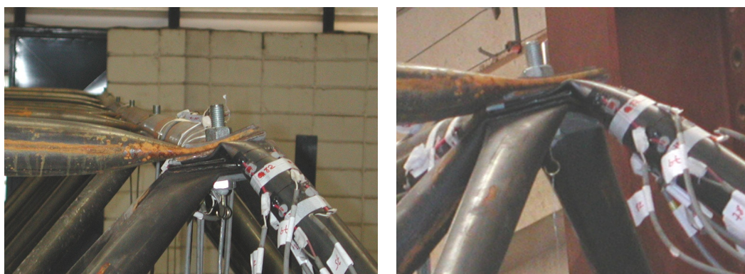
Figura 4.7 - Configuração de colapso do nó de canto da treliça TE1
