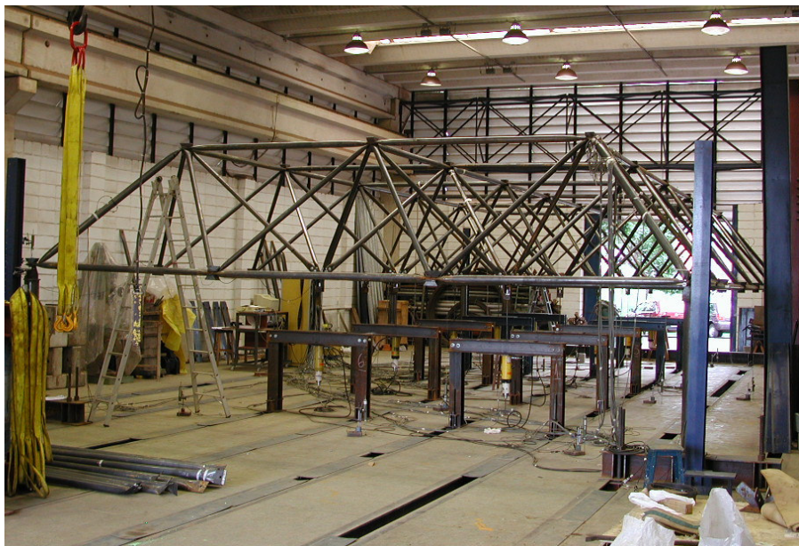
Figura 4.68 - Vista geral da treliça TE1-R
