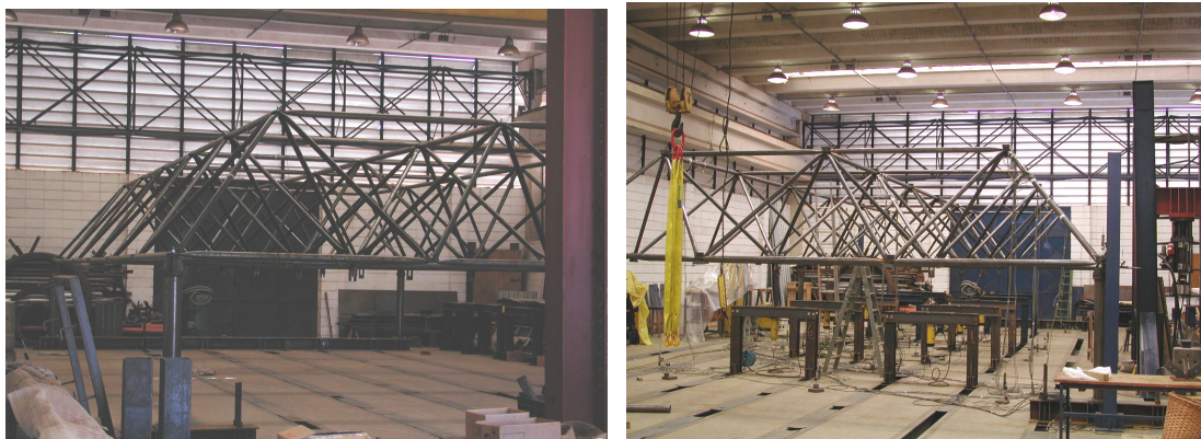
Figura 3.2 - Vista geral da estrutura
