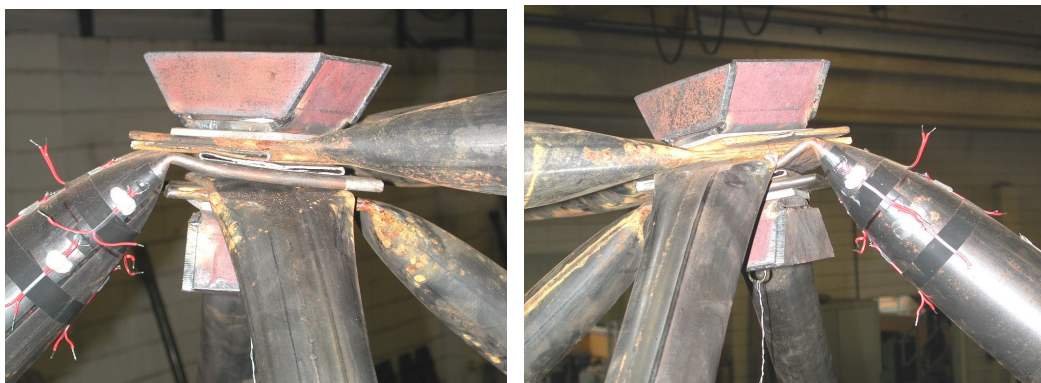
Figura 4.71 - Configuração de colapso para os nós da treliça TE2-R
