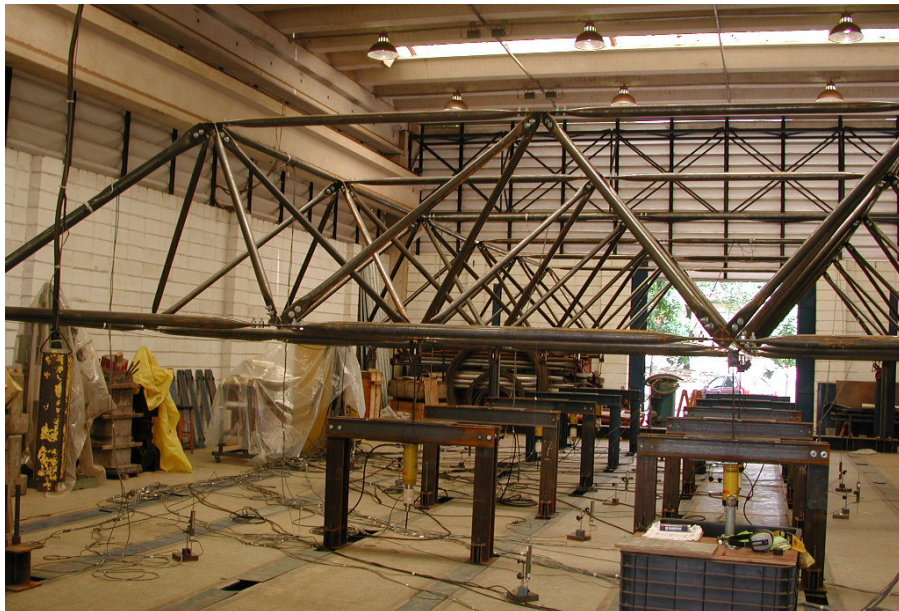
Figura 5.1 - Visão geral da treliça TE4
