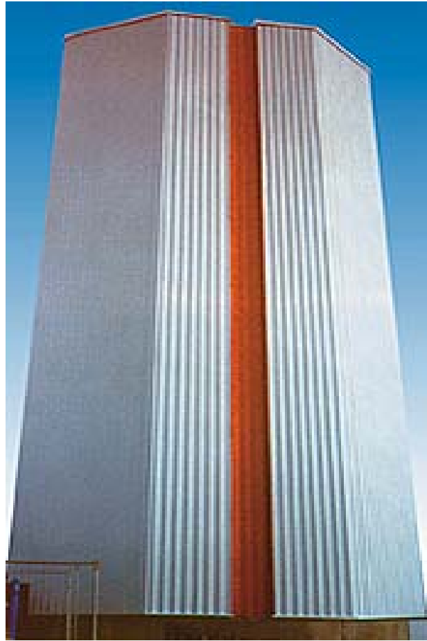
Figura 7 – Fachada <www.bemo.com.br acesso 16-09-2002>
