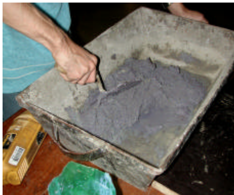
Figura 3.11 – Moldagem com colher de pedreiro logo após colocação de água
