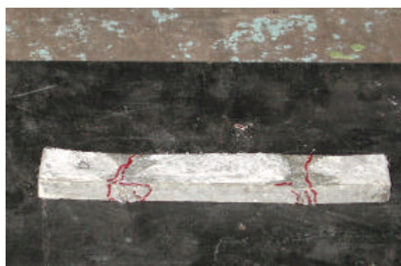
Figura 4.57 – Afundamento de placa de 10mm em duas linhas
