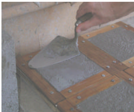
Figura 3.15 – Acabamento com colher de pedreiro embebida em água após adensamento
