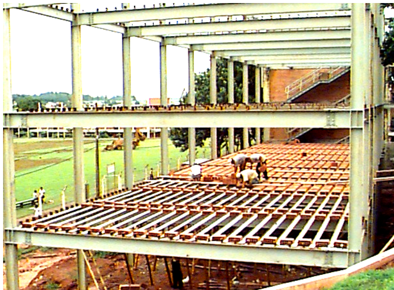
FIGURA 2.3: Lajes de piso (na fase de construção) executadas na EESC/USP:
