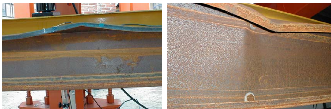
a) Instabilidade distorcional ocorrida no meio do vão da viga.
