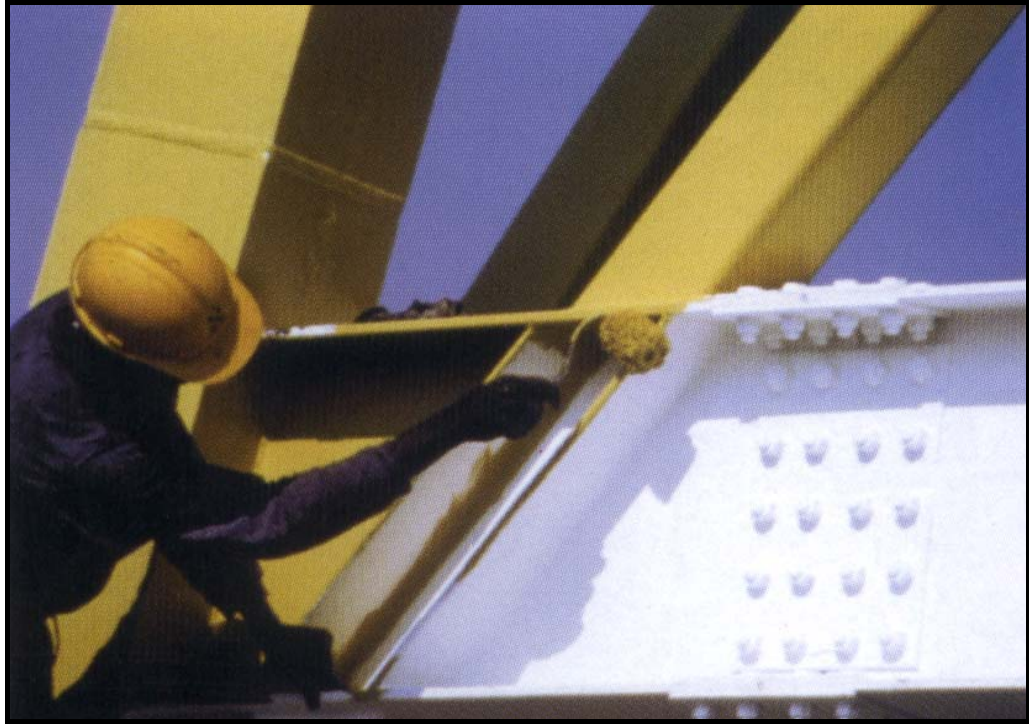
FIGURA 3.25: Aplicação da tinta intumescente.
