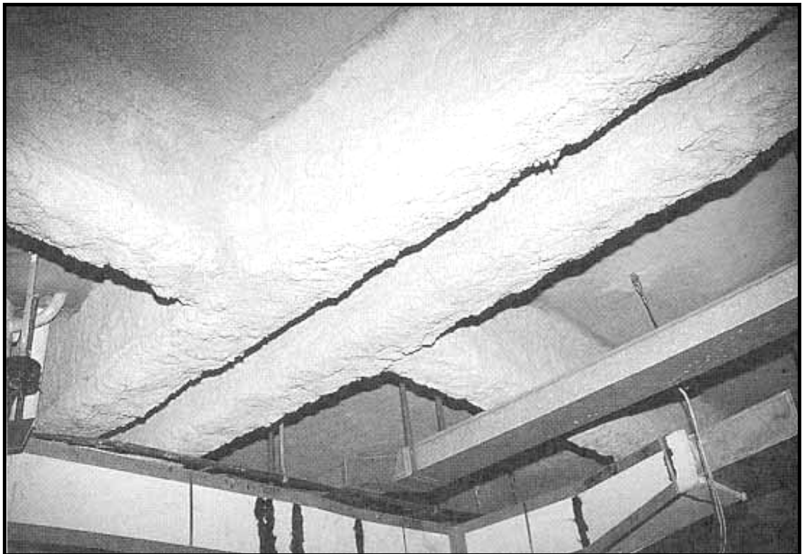
FIGURA 3.15: Argamassa à base de vermiculita. Fonte: Silva (2001a).
