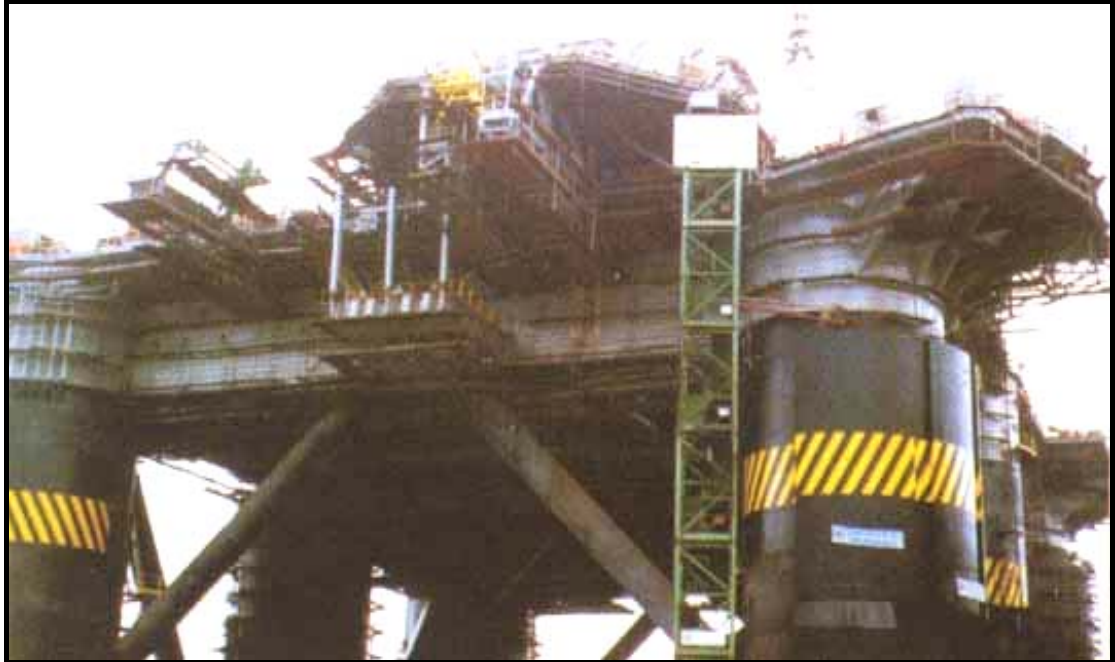
FIGURA 3.16: Argamassa vermiculítica na plataforma P-19/Petrobrás.
