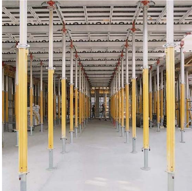
Figura 3.1 - Aplicação de escoras pontuais
