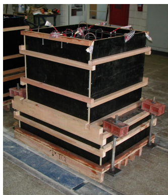
Armadura na fôrma
