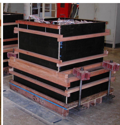
Armadura na fôrma
