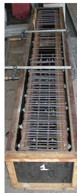
Armadura na fôrma
