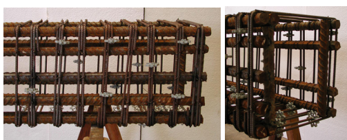
Armadura no trecho de embutimento e barras soldadas na armadura
