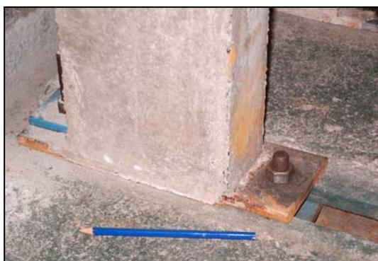
Figura 5.30. Detalhe da fixação dos pórticos.
