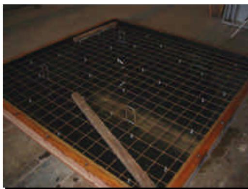
Figura 5.33 – Fôrma para placa de 2 m x 2 m
