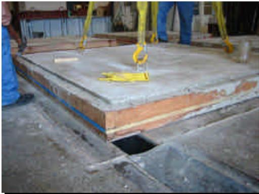
Figura 5.37 – Retirada das placas das fôrmas
