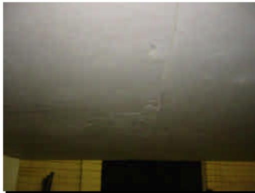
Figura 5.63 – Configuração das fissuras na face inferior, modelo PCA3
