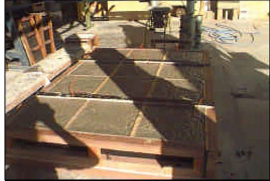
Figura 5.2 – Fôrma para seis vigas, sobre a mesa vibratória
