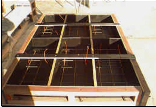
Figura 5.1 – Posicionamento da armadura
