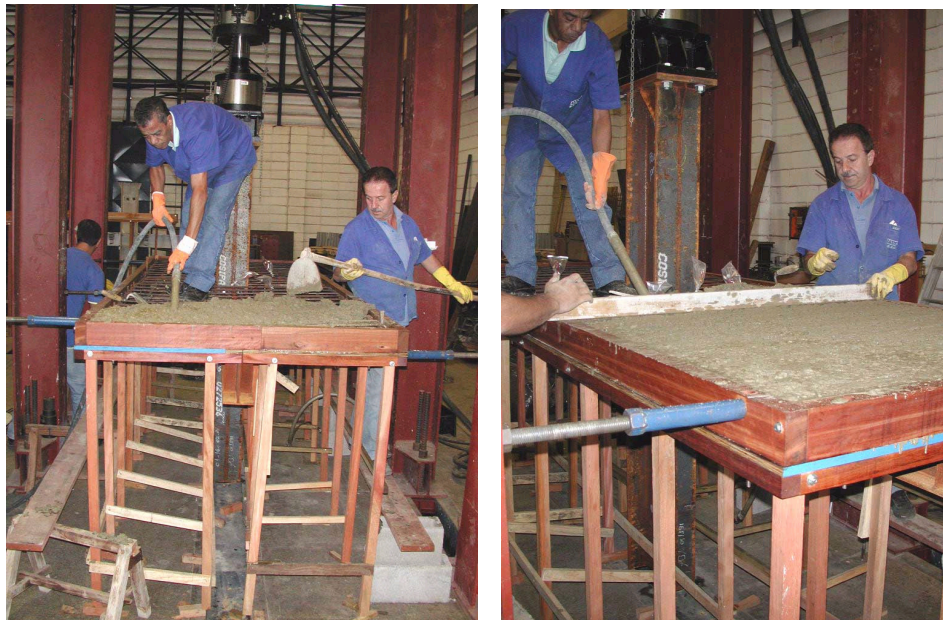
Figura 5.30 – Concretagem da laje do modelo
