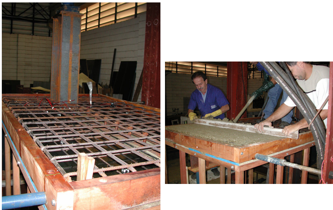
Figura 5.35 – Modelo “T” misto antes e durante a concretagem
