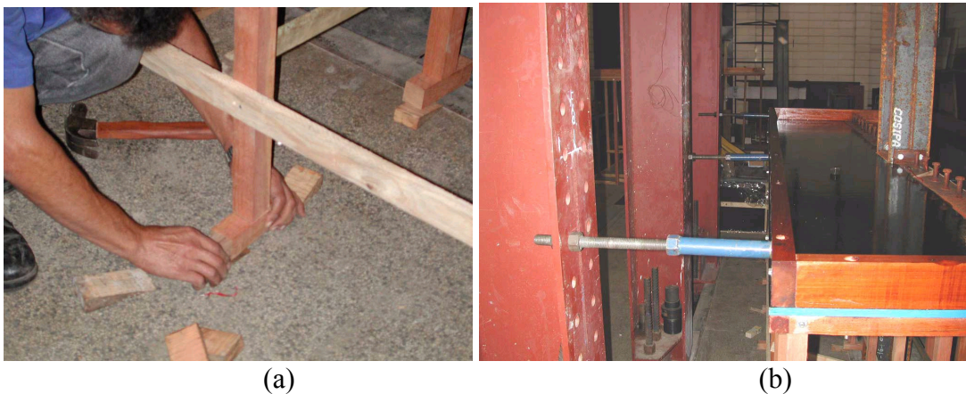
Figura 5.26 – Colocação das cunhas na base dos pontaletes e travamento da forma
