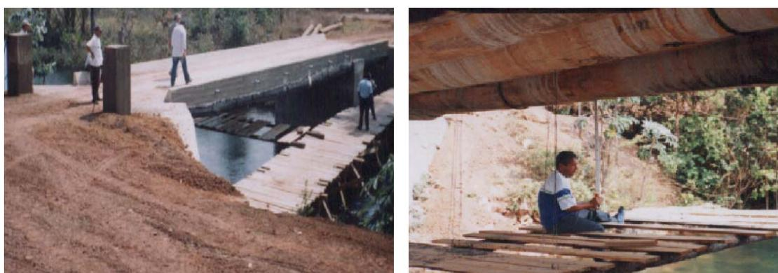
Figura L13 – Detalhes da ponte concluída e posicionamento da régua para leitura dos deslocamentos.
