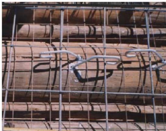
Figura L11 – Posicionamento dos grampos de união das vigas e posição dos conectores.
