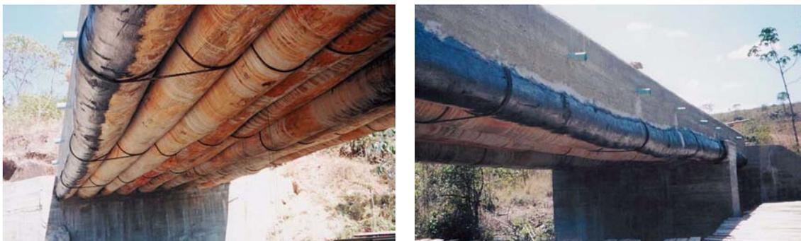
Figura L12 – Detalhes da ponte concluída: travamentos e impermeabilização das vigas externas.
