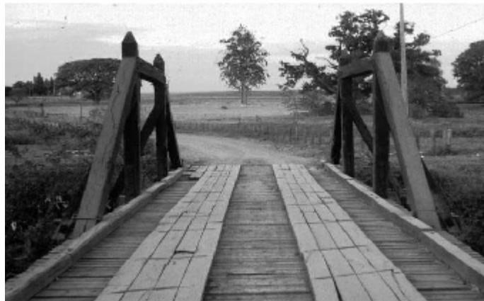
Figura 1 – Tabuleiro formado por pranchas transversais. Fonte LaMEM.
