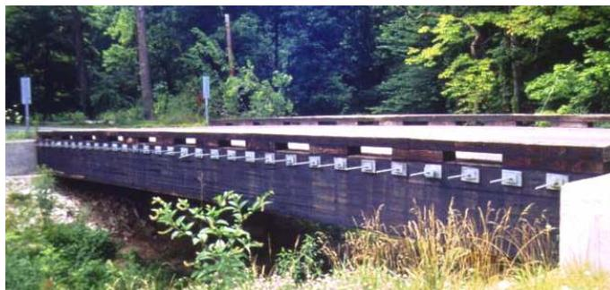
Figura 8 – Tabuleiro protendido transversalmente de seção T, com vigas laminadas coladas e revestimento asfáltico. (EUA).
