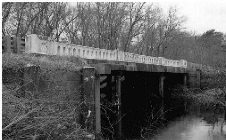
Figura 50 - Ponte Omar Bridge de madeira e concreto construída em 1932. Pendleton (1996).
