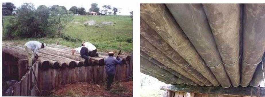
Figura K6 – Lançamento das vigas de madeira.
