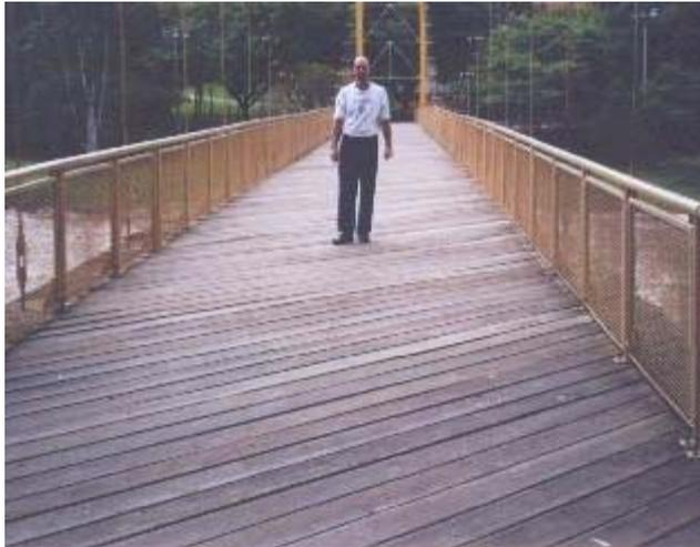
Figura 3 – Tabuleiro com pranchas superpostas formando ângulos de 45° com o eixo longitudinal da ponte. Fonte: LaMEM.
