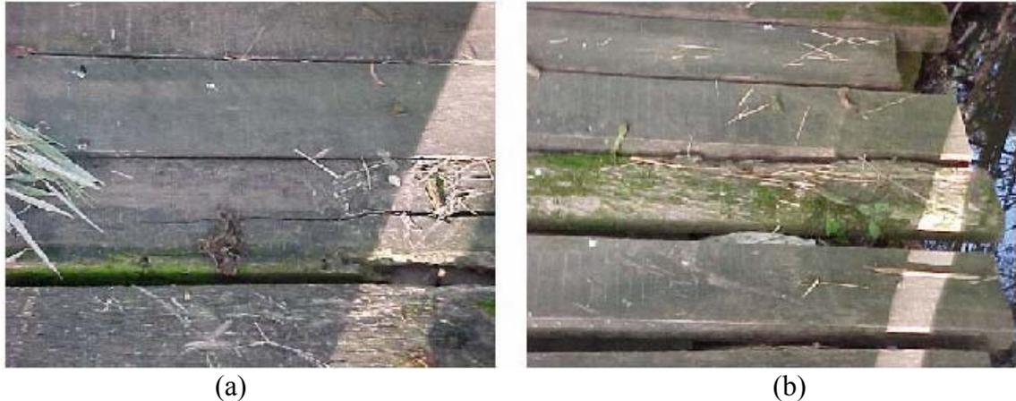
Figura 4 - (a) e (b), deterioração e apodrecimento precoce de algumas pranchas do tabuleiro sem tratamento. Ponte Marins, 2002, Piracicaba – SP. Fonte: LaMEM.
