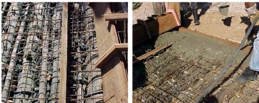
Figura K9 - Detalhes do tabuleiro de madeira concluído e início de concretagem.
