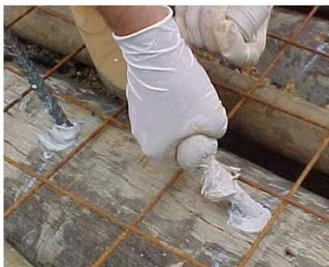
Figura 56 - Operação de aplicação da resina em canteiro de obras.
