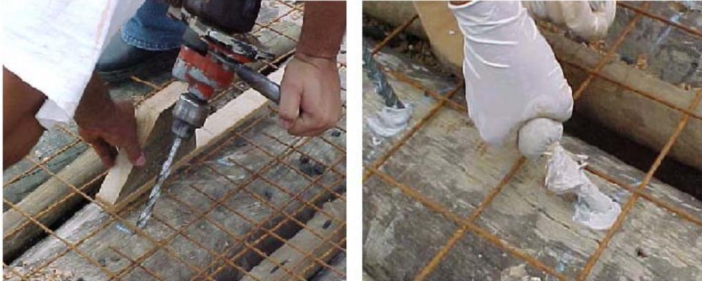
Figura K7 – Detalhe da furação e da colagem dos conectores.
