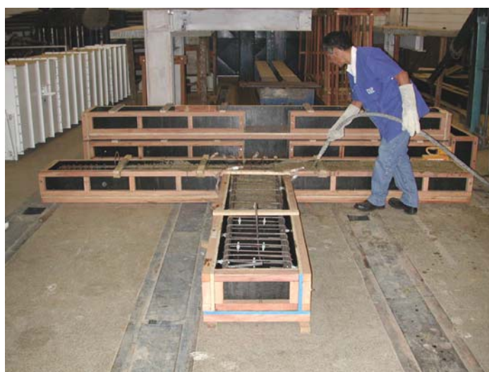
Figura 6.20: Adensamento do concreto na fôrma
