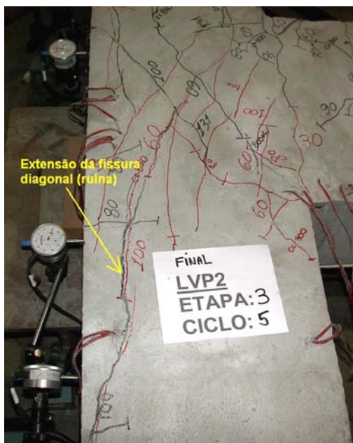
Figura 6.37: Propagação da fissura diagonal do nó na ruína: Forças de sentido positivo
