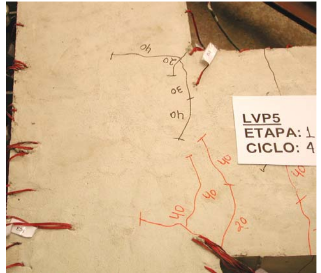
Primeiras fissuras visíveis no nó de pórtico
