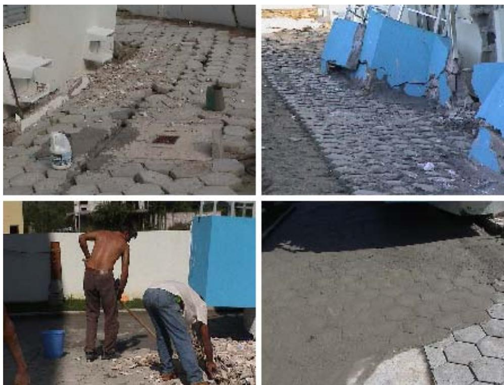
**Figura 4.10 - Impermeabilização do piso com argamassa aditivada – Maffei Engenharia.**
