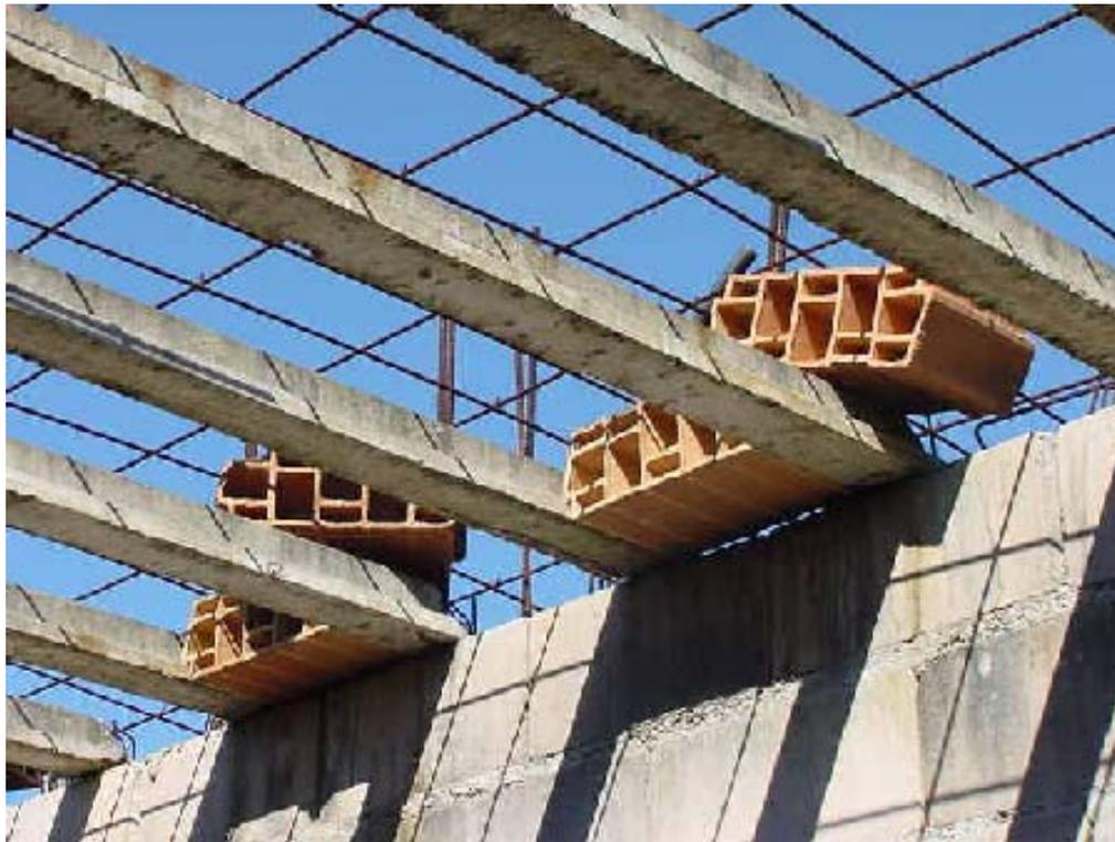
**Figura 2.8 - Laje de transição – Maffei Engenharia.**
