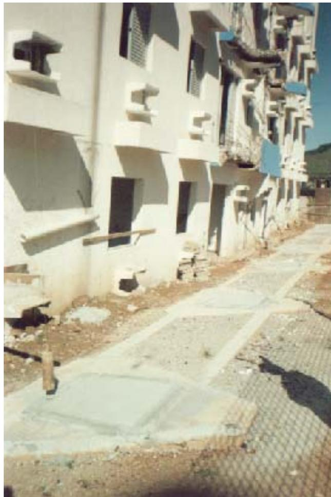
**Figura 4.18** - *Fundaç o provis ria posicionada na parte externa do edif cio.*
