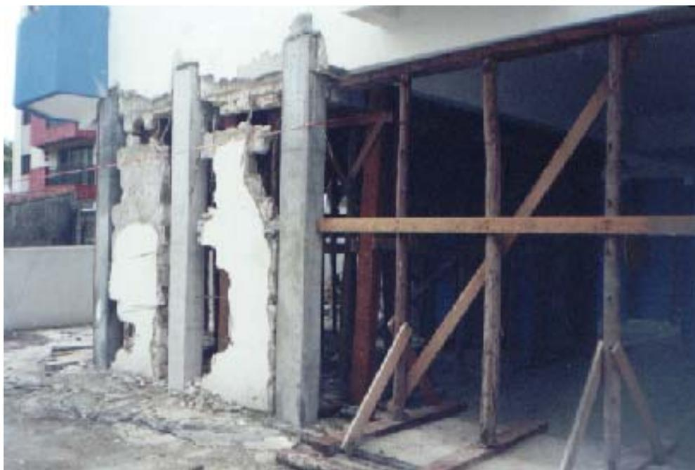
**Figura 4.5 - Reforço com três colunas de concreto armado– Maffei Engenharia.**
