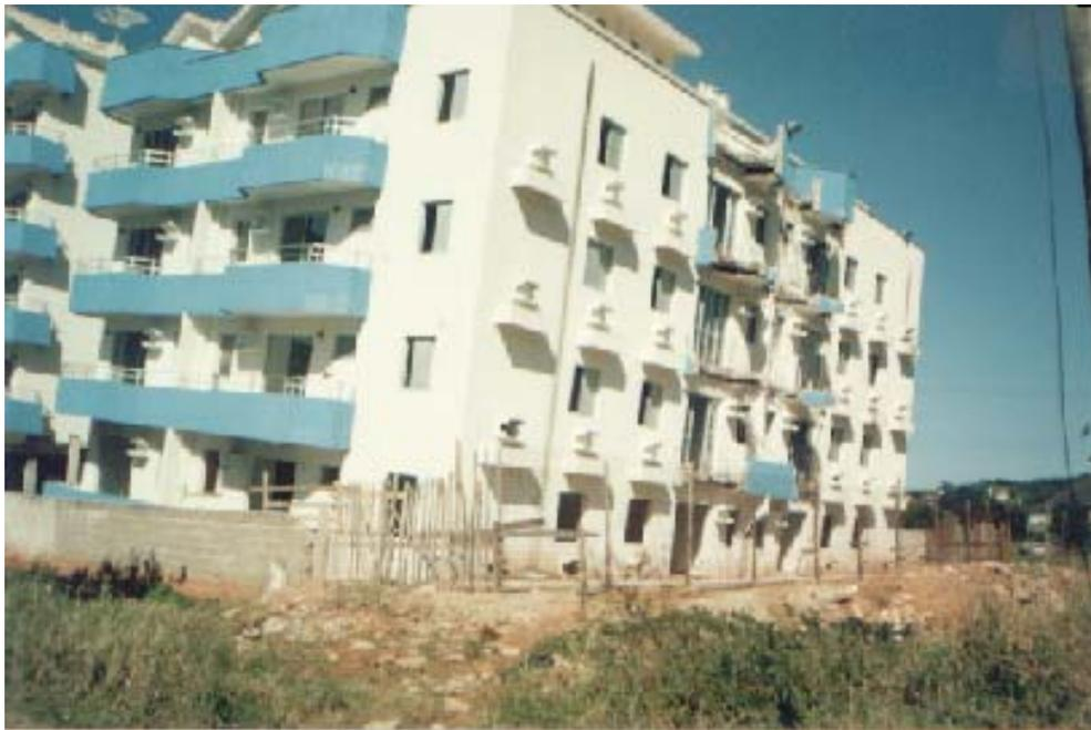
Figura 4.17 - Sacadas demolidas para permitir a execução de algumas estacas.
