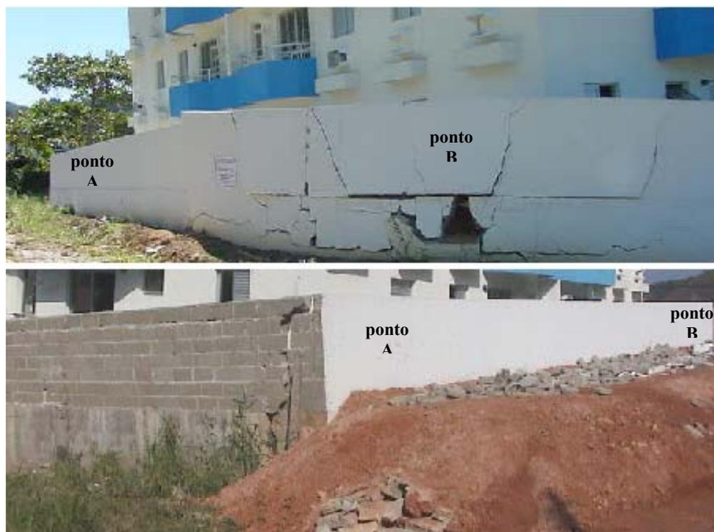
**Figura 4.9 - Antes e depois do acréscimo de solo junto à divisa do terreno– Maffei Engenharia.**
