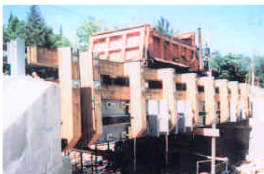
FIGURA 14- Prova de carga na ponte de Byron (DAGHER & ALTIMORE et al., 1999).
