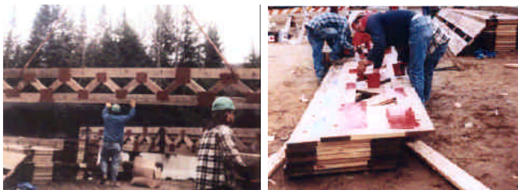
FIGURA 9- Lançamento das treliças e pintura dos conectores (DAGHER, ALTIMORE et al., 1999).
