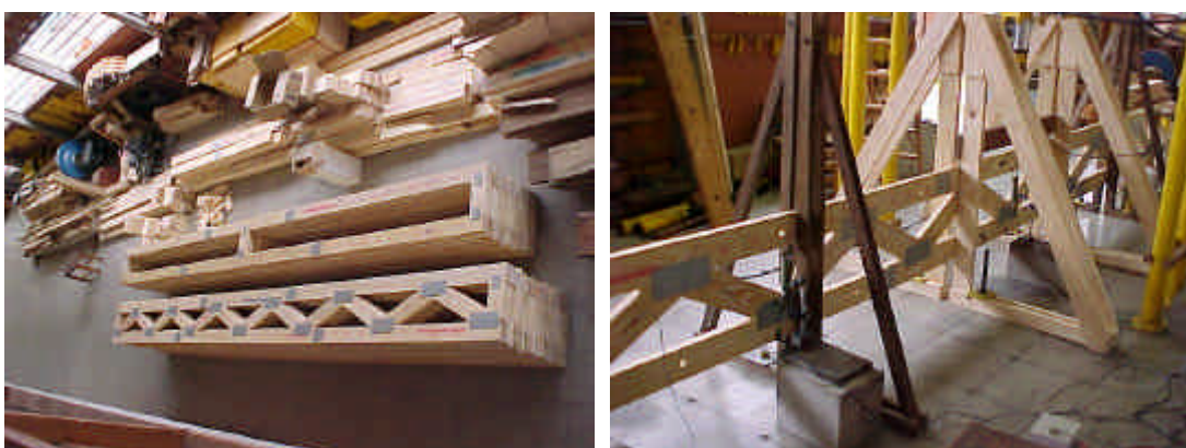
FIGURA 98- (a) Prensagem (b) Furação para posterior passagem das barras de protensão.
