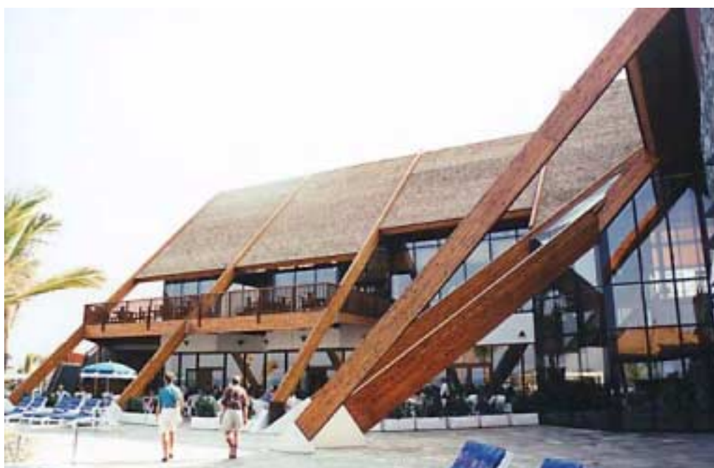
Figura 3 – Estrutura de cobertura em madeira laminada colada
