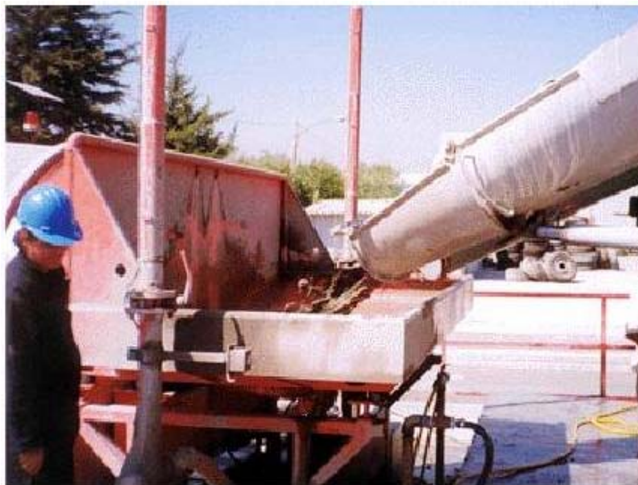
Figura 2.2 – Concreto residual sendo entregue à planta de reciclagem
