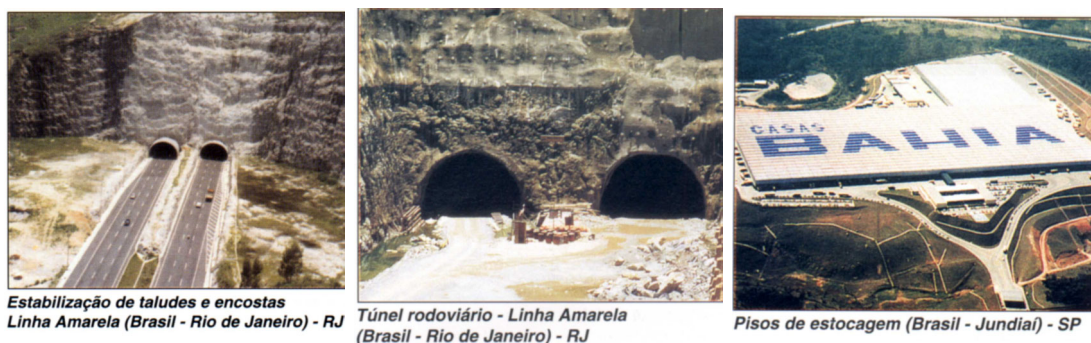
Figura 2.1 – Exemplos da utilização de fibras de aço na Linha Amarela e no depósito das Casas Bahia.
