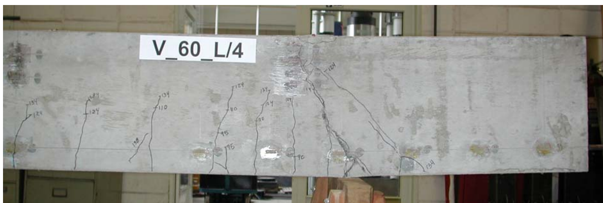
Figura 6.93 – Detalhes da fissuração da V_60_L/4.
