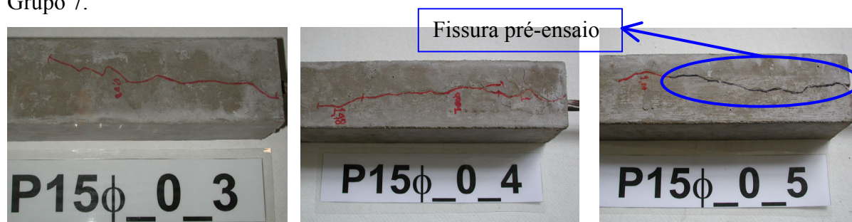
Figura 5.15 – Fissuração dos prismas do Grupo 7.
