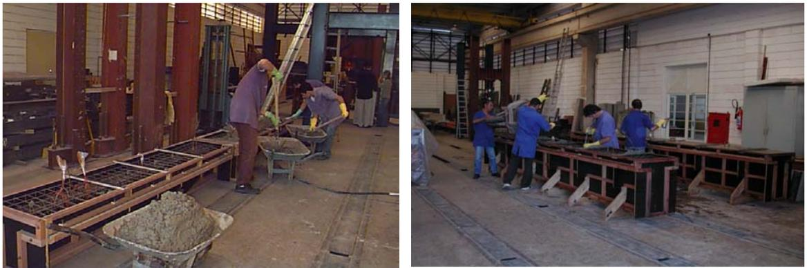
**Figura 7.42** – Concretagem das vigas das séries A1 e A2.
