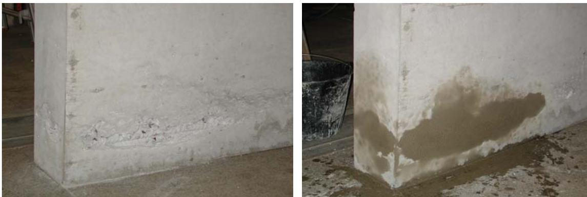
**Figura 7.44** – Reparo localizado na viga VS-0 (antes e depois).
