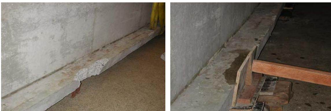
**Figura 7.45** – Reparo localizado na viga VS-2 (antes e depois).
