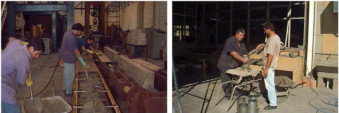
**Figura 7.43** – Adensamento das vigas da série A1 e moldagem dos corpos-de-prova.
