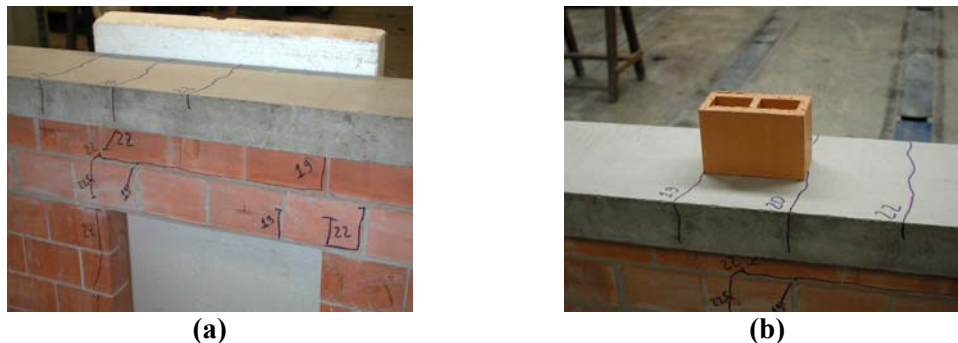
FIGURA 4.4-11 Fissuração ocorrida no lintel do modelo PPCG1: (a) Vista geral e (b) Detalhe da fissuração na laje.
