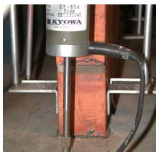
FIGURA 4.3-29 Detalhe da abertura da fissura no canto tracionado da parede P2: modelo PPSG2.
