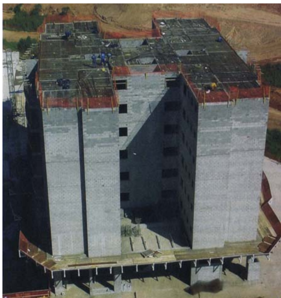
FIGURA 1.1-2 Construção de edifício com 14 pavimentos [Revista Techne – Edição 75].
