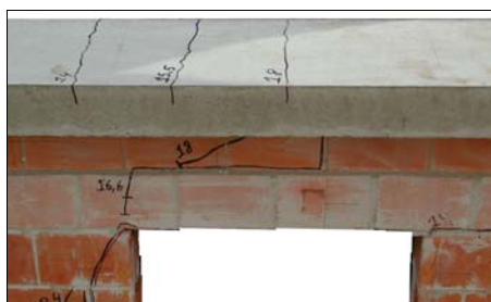
FIGURA 4.3-35 Fissuração do lintel do modelo PPSG2.
