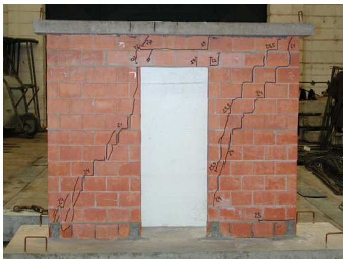
FIGURA 4.4-13 Vista geral do modelo PPCG1 após a realização do ensaio.
