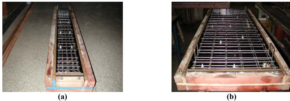
FIGURA 3-23 Distribuição das armaduras para lajes do painel porta: (a) Lajes de topo; (b) Lajes de base.
