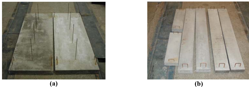
FIGURA 3-24 Lajes após concretagem: (a) Lajes de base para painéis porta e janela com graute; (b) Lajes de topo para painéis isolado e porta.
