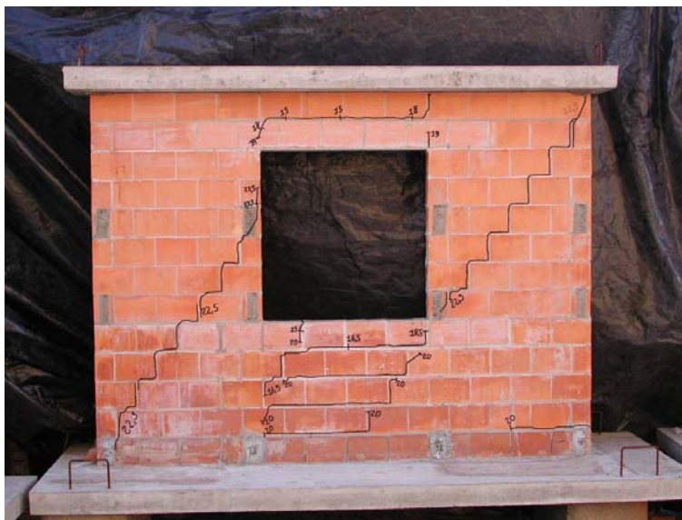
FIGURA 4.6-19 Vista geral do modelo PJC2 após realização do ensaio.
