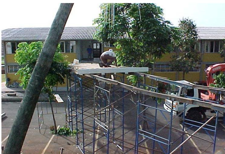
FIGURA 42 - Montagem do Tabuleiro
