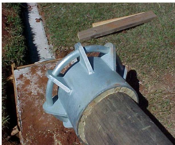
FIGURA 28 - Detalhe da Conexão do Topo do Mastro
