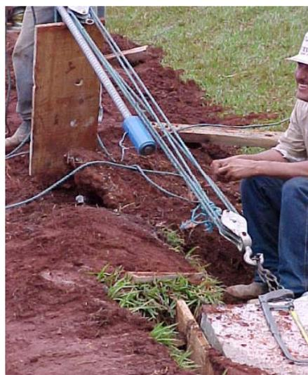
FIGURA 36 – Ancoragem dos Estais de Sustentação do Mastro (Pilar Central)
