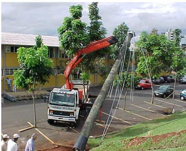
FIGURA 33 - Içamento do Mastro (Pilar Central)
