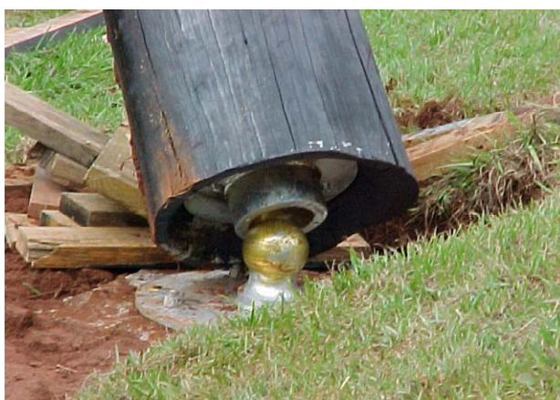
FIGURA 34 – Colocação do Mastro sobre o Apoio
