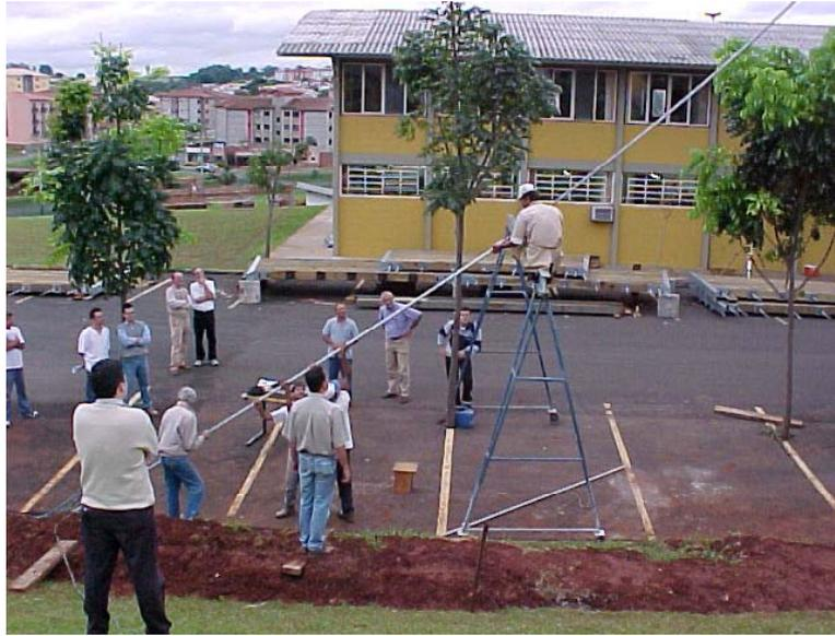
FIGURA 37 - Estais de Sustentação do Mastro (Pilar Central)
