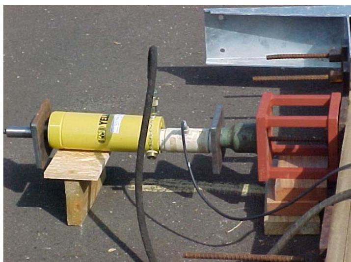
FIGURA 23 – Fabricação de um Módulo – Protensão das Barras de Aço
