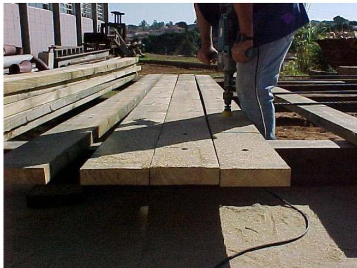
FIGURA 20 – Fabricação de um Módulo- Furação das Lâminas
