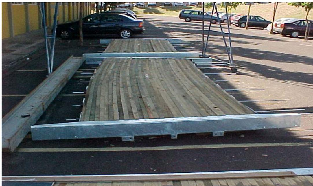
FIGURA 18 – Encabeçamento dos Módulos do Tabuleiro
