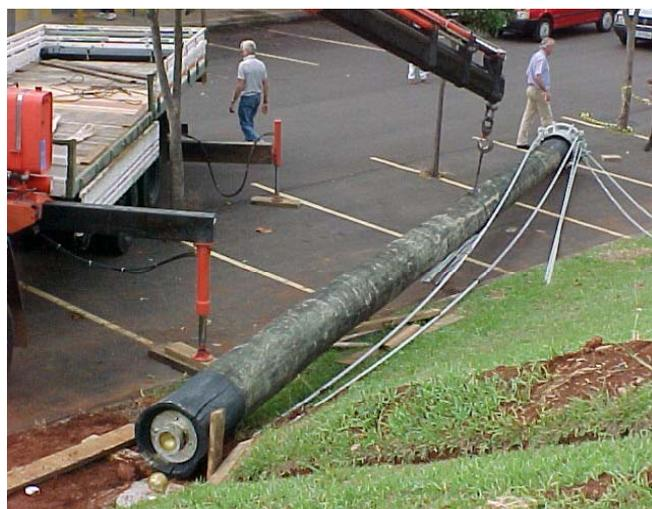
FIGURA 32 – Início do Içamento do Mastro (Pilar Central)
