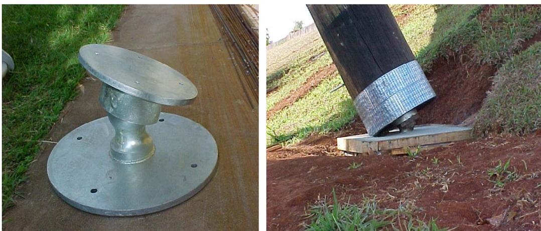
FIGURA 29 - Detalhe da Conexão da Base do Mastro
