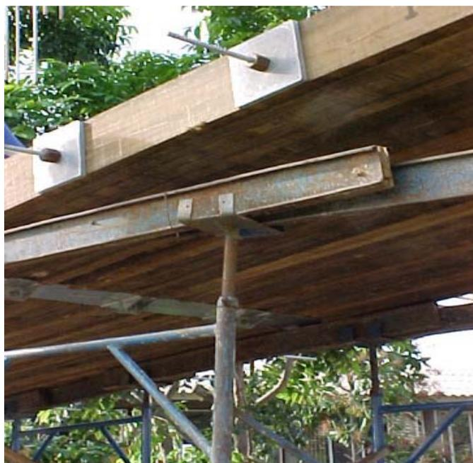
FIGURA 39 - Sistema de Regulagem do Greide do Tabuleiro
