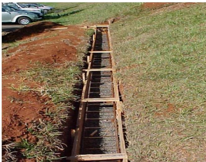
FIGURA 27 - Fundação com Blocos Interligados por Escoras de Concreto
