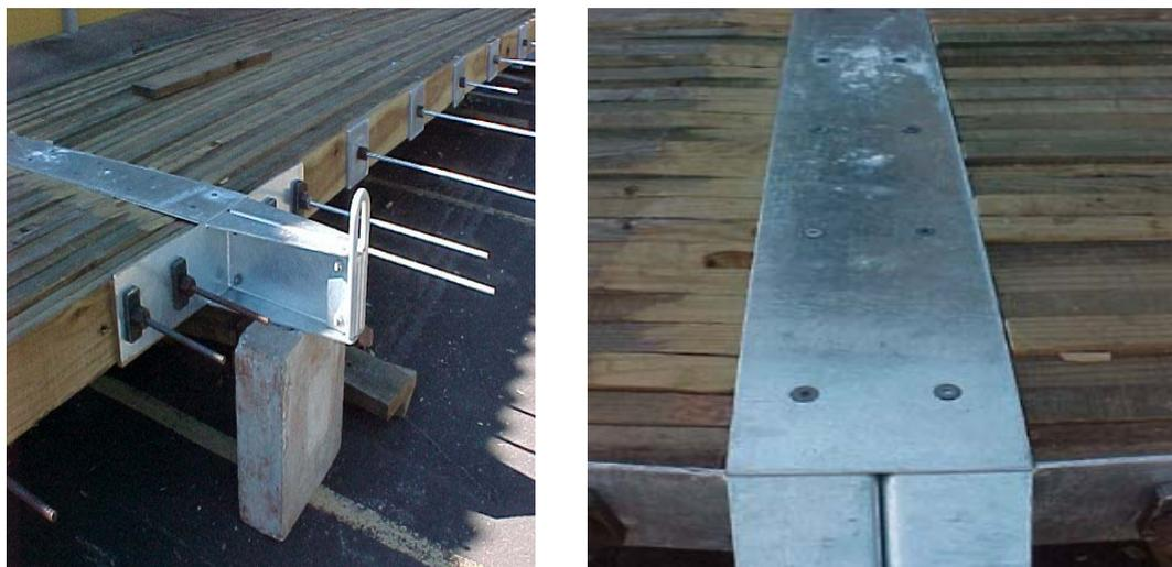
FIGURA 19 – Ligação dos Módulos do Tabuleiro
