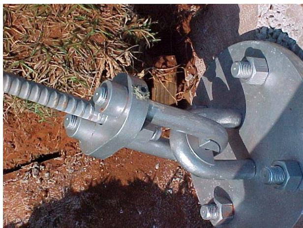
FIGURA 35 – Detalhe do Apoio do Estal de Sustentação
