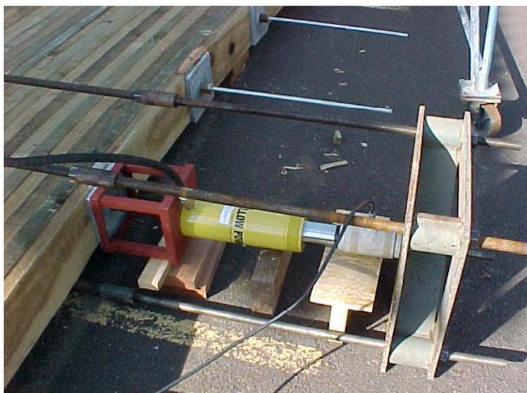
FIGURA 24 – Fabricação de um Módulo – Dispositivo de Aplicação de Curvatura
