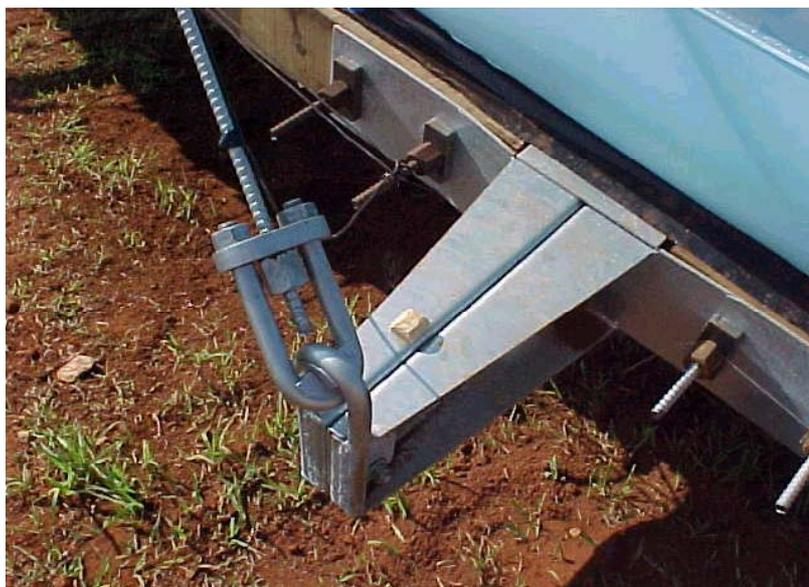
FIGURA 48 - Detalhe das Conexões dos Estais
