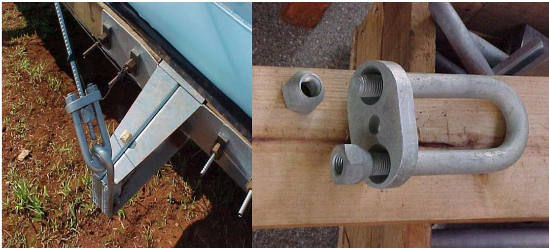
FIGURA 79 - Detalhes dos Estais e dos Cabos de Sustentação do Mastro
