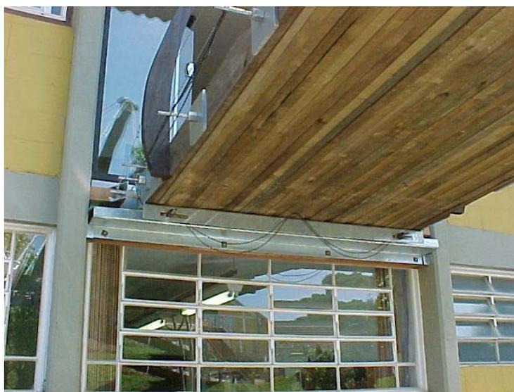
FIGURA 50 - Apoio da Passarela no Prédio do SET LaMEM
