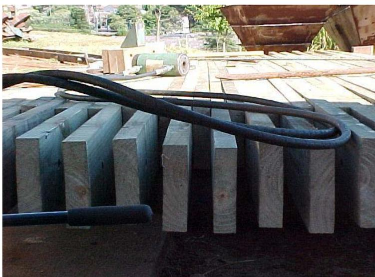
FIGURA 16 – Ligação Dentada dos Módulos do Tabuleiro
