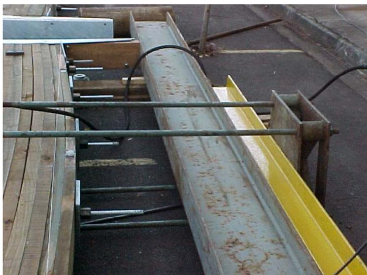
FIGURA 22 – Fabricação de um Módulo - Aplicação de Curvatura
