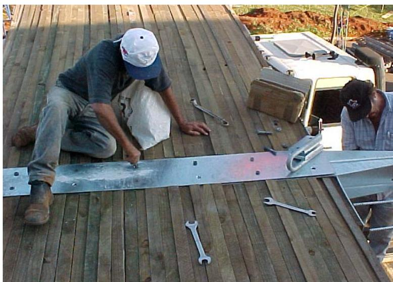
FIGURA 43 – Ligação dos Perfis através de Chapa Metálica Parafusada
