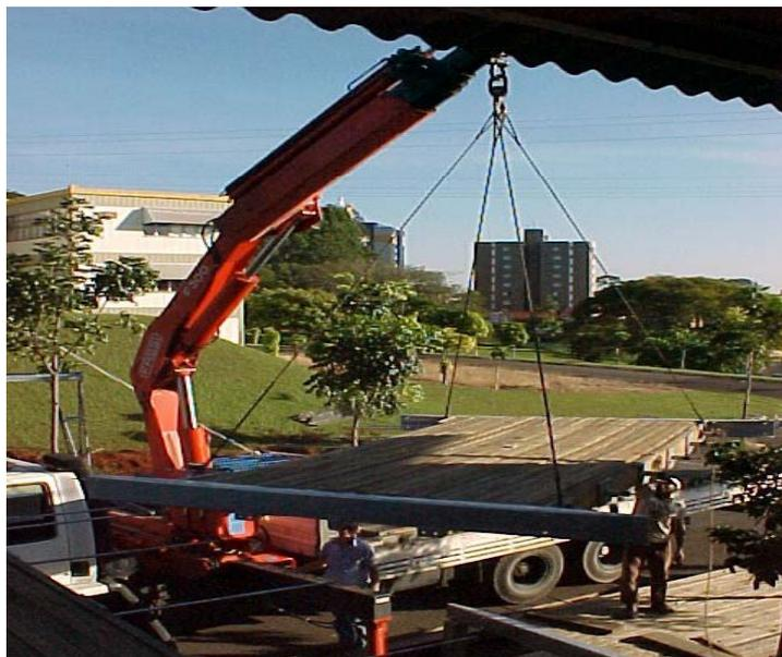
FIGURA 41 - Detalhe da Aproximação do Módulo do Tabuleiro
