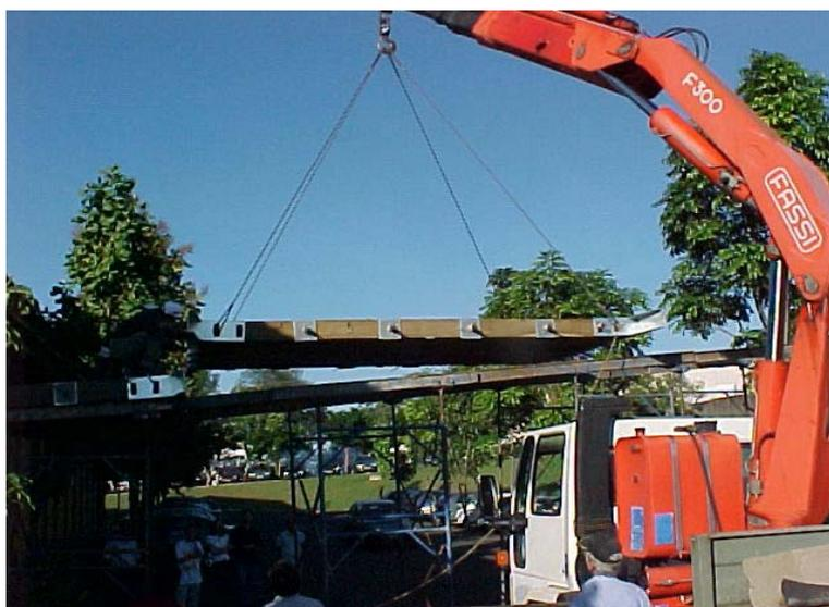
FIGURA 40 – Içamento de um Módulo do Tabuleiro
