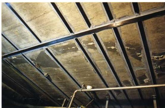
**Figura 2.3 – Reforço por colagem de lâminas flexíveis de fibras de carbono**
