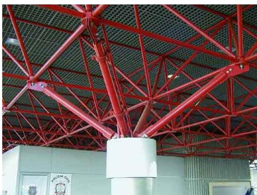
**Figura 3.10 – Detalhe de apoio de treliça espacial utilizando pirâmide invertida**
