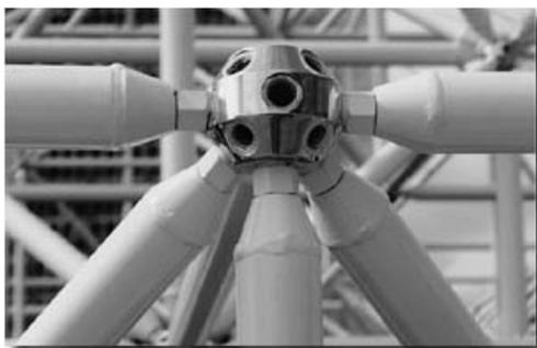
**Figura 3.29 – Sistema de ligação ALUAÇO SPACE – Fonte:
