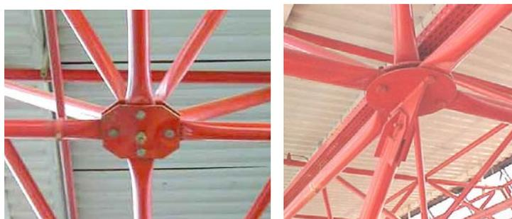
Figura 3.38 – Nó de aço com chapa circular e octogonal
