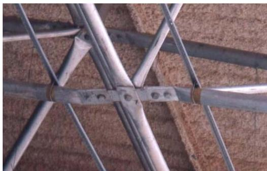
**Figura 3.35 – Colapso de um nó típico com chapa complementar**
