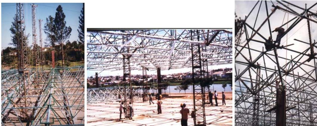
**Figura 3.55 - Técnica *LIFT-SLAB* de montagem para treliças espaciais**
