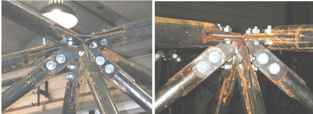
Figura 5.27 – Detalhes da ligação da treliça TE5
