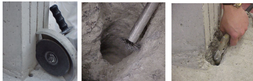
(c) execução dos cortes no cobrimento
