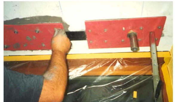
(b) fixação dos laminados
