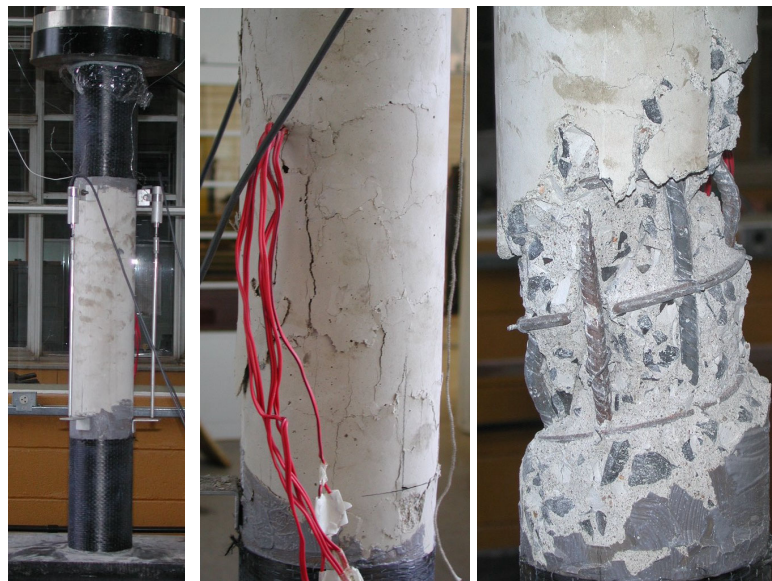
Figura 6.18: Fotos do pilar original de seção transversal circular
