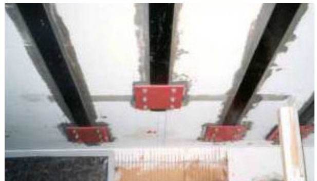
(d) aspecto final dos laminados protendidos
