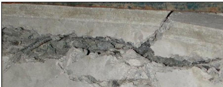
**Figura 5.37 – Detalhe da perda de estabilidade da armadura de compressão da viga VS-01.**
