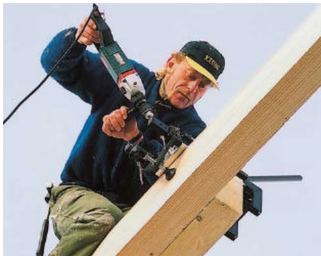
Figura 2.10 - Exemplo de utilização no canteiro de obras. FONTE: SFS (2002).
